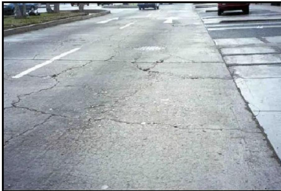
**Figura 6.** Losa dividida. (Booz Allen et al., 1999)
