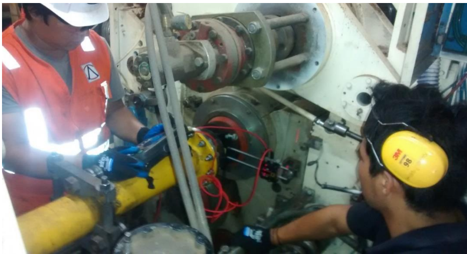
Figura 12. Inspección de equipos
