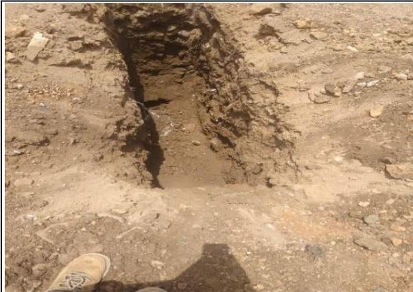
Se realizó la excavación y extracción de la tercera muestra de la calicata N° 03, realizado en el kilómetro 8+020.
