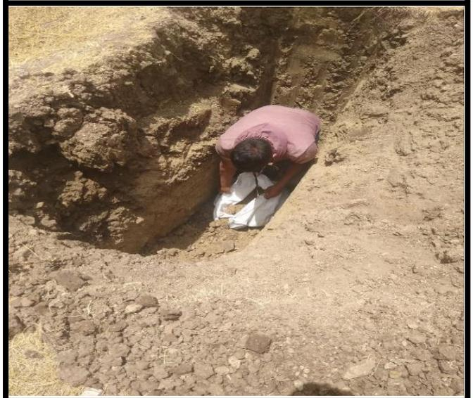
Se realizó la excavación y extracción de la primera muestra de la calicata N° 02, realizado en el kilómetro 7+020.
