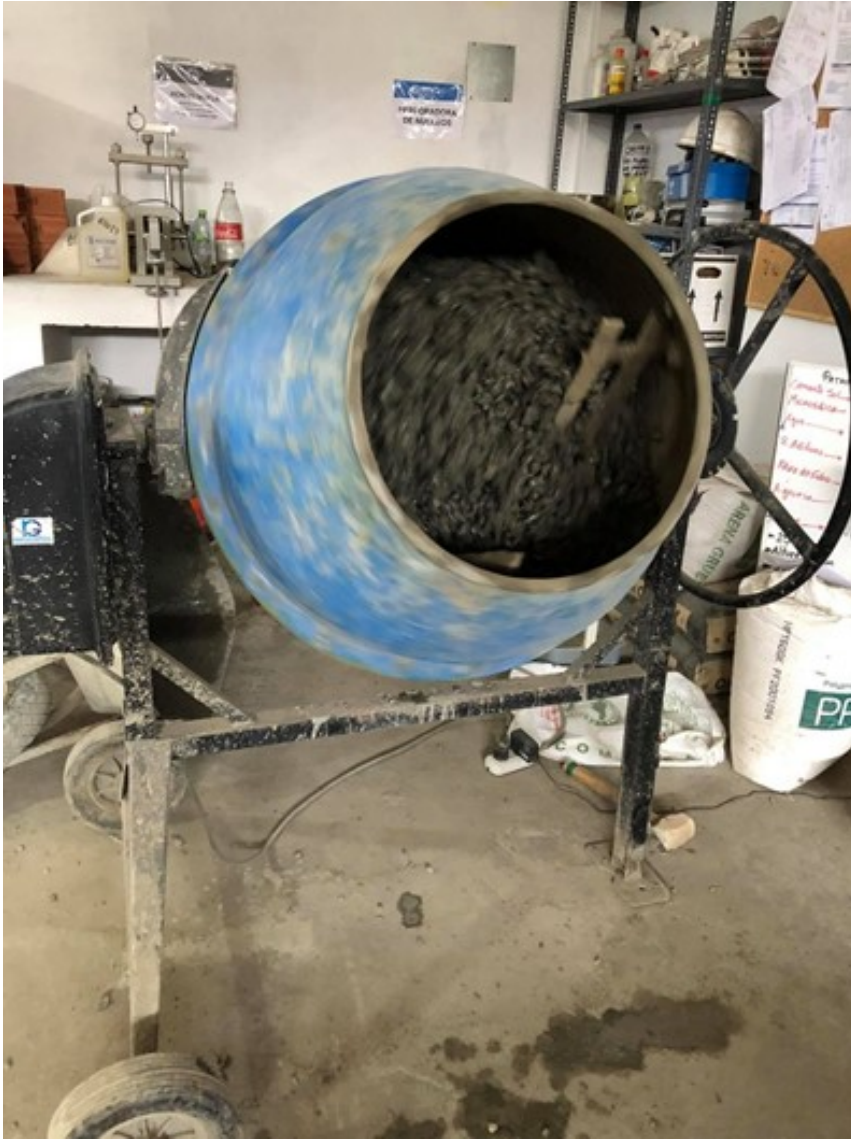
Elaboración de la mezcla. Fuente: Elaboración Propia.
