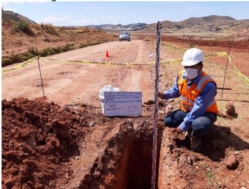
Figura 4.1. Excavación de calicatas
