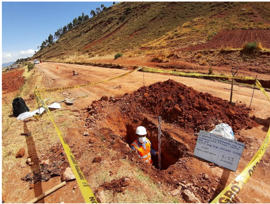
Figura N° 03: trabajos de campo excavación de calicatas.
