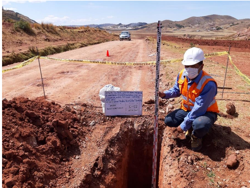
Figura N° 04: trabajos de campo excavación de calicatas.
