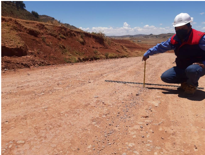
Figura N° 02: trabajos de campo medidas de ahuellamiento.
