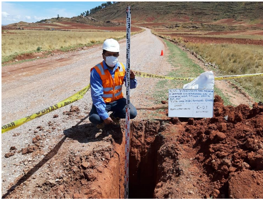
Figura N° 05: trabajos de campo excavación de calicatas.
