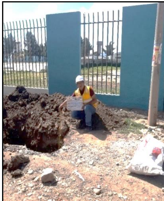
Figura 34. Obtención de muestras por calicatas. Fuente: Elaboración propia.
