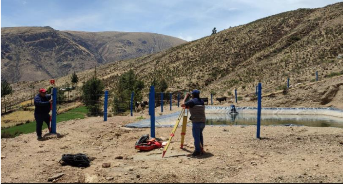
Figura 80: Trabajos de Levantamiento Topográfico
