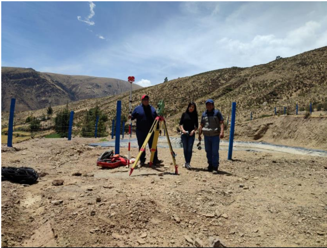
Figura 79: Progresiva 00+000 de canal existente
