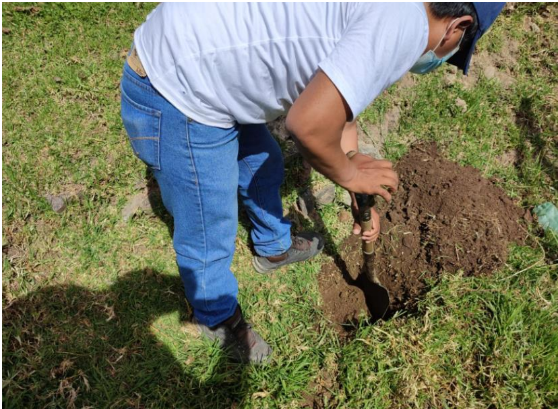
Figura 85: Excavación de Calicata-1.
