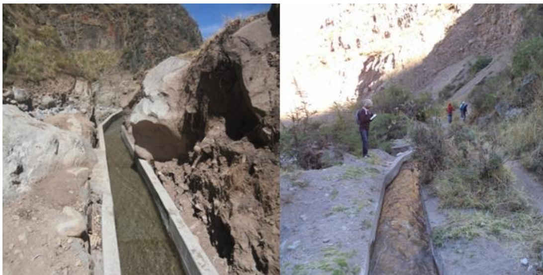
Figura 82: Canal Existente Entubado Checchewa.
