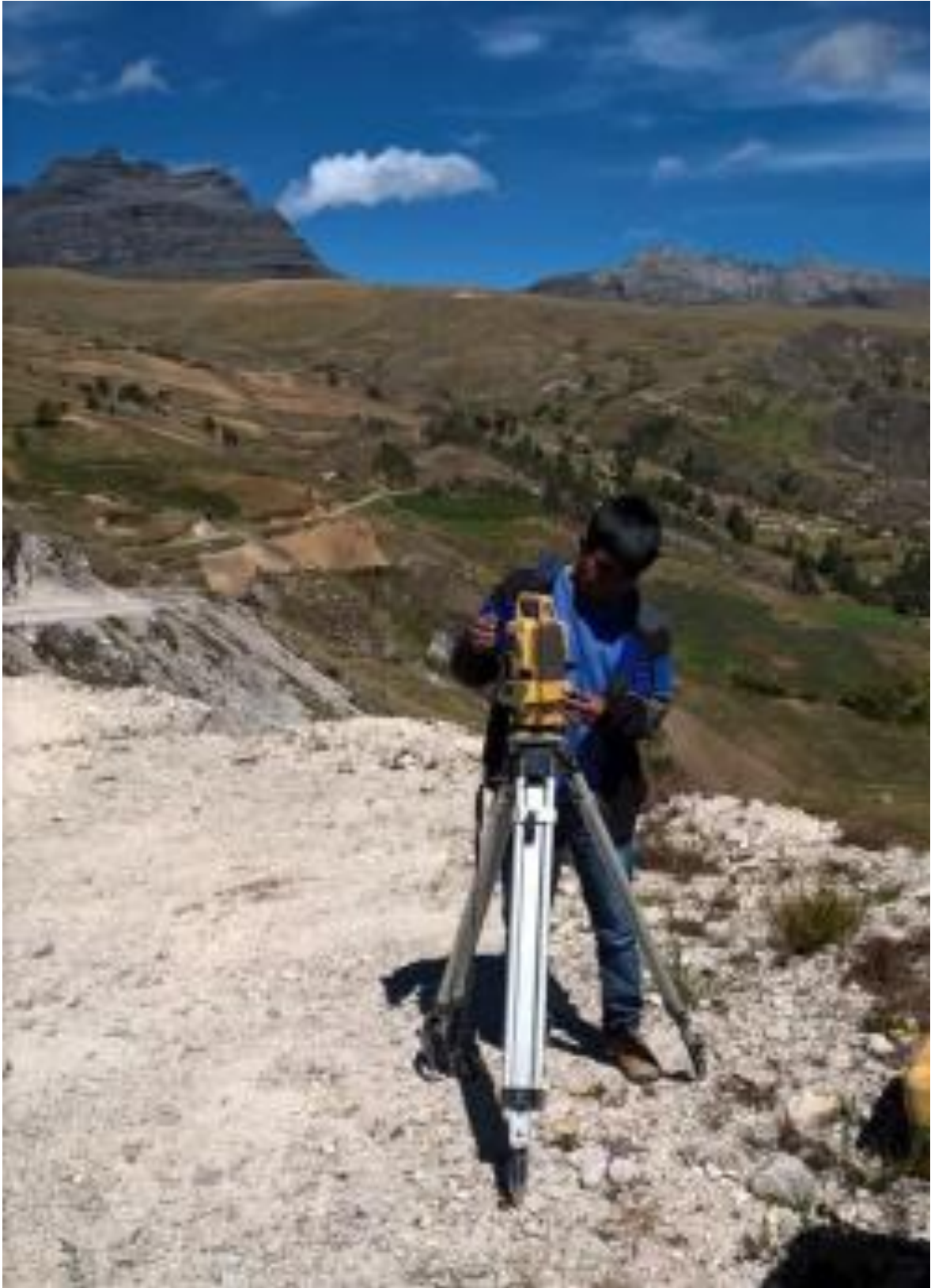
Figura 05. Instalación de equipo topográfico: Estación total. Fuente: Elaboración propia.
