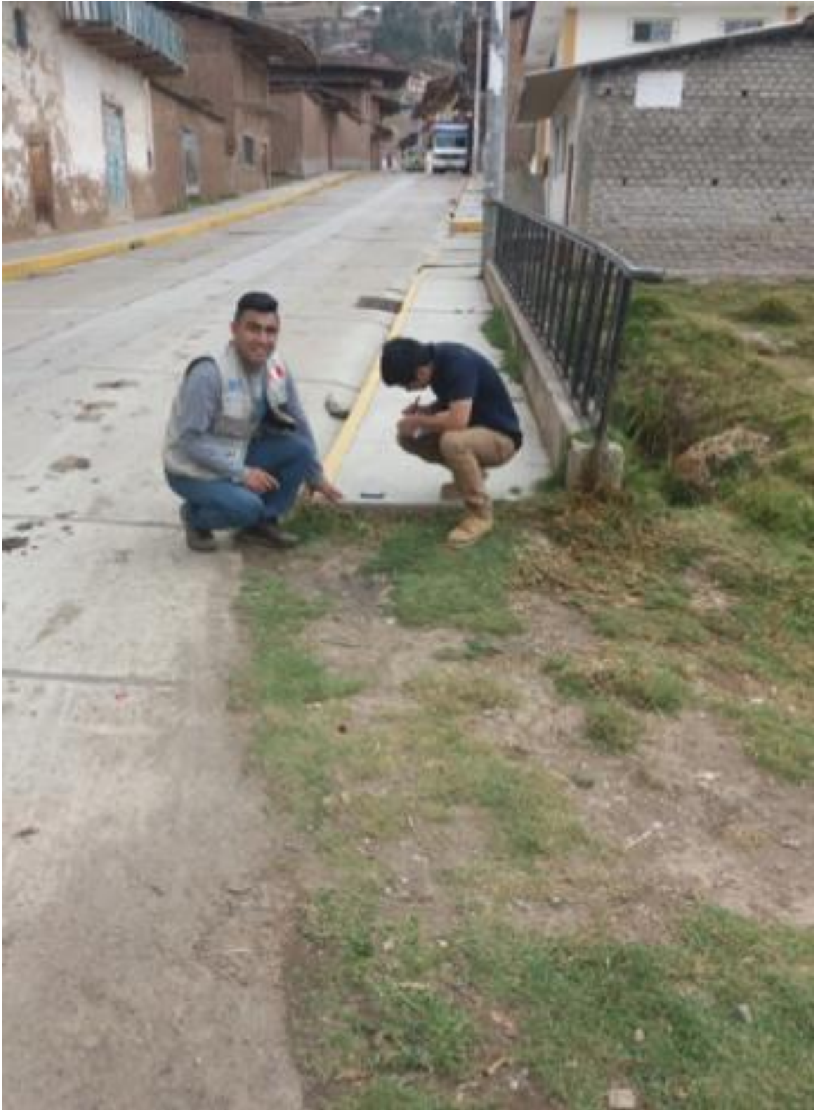
Figura 02. Punto inicial de la propuesta de mejoramiento de carretera. Fuente: Elaboración propia.
