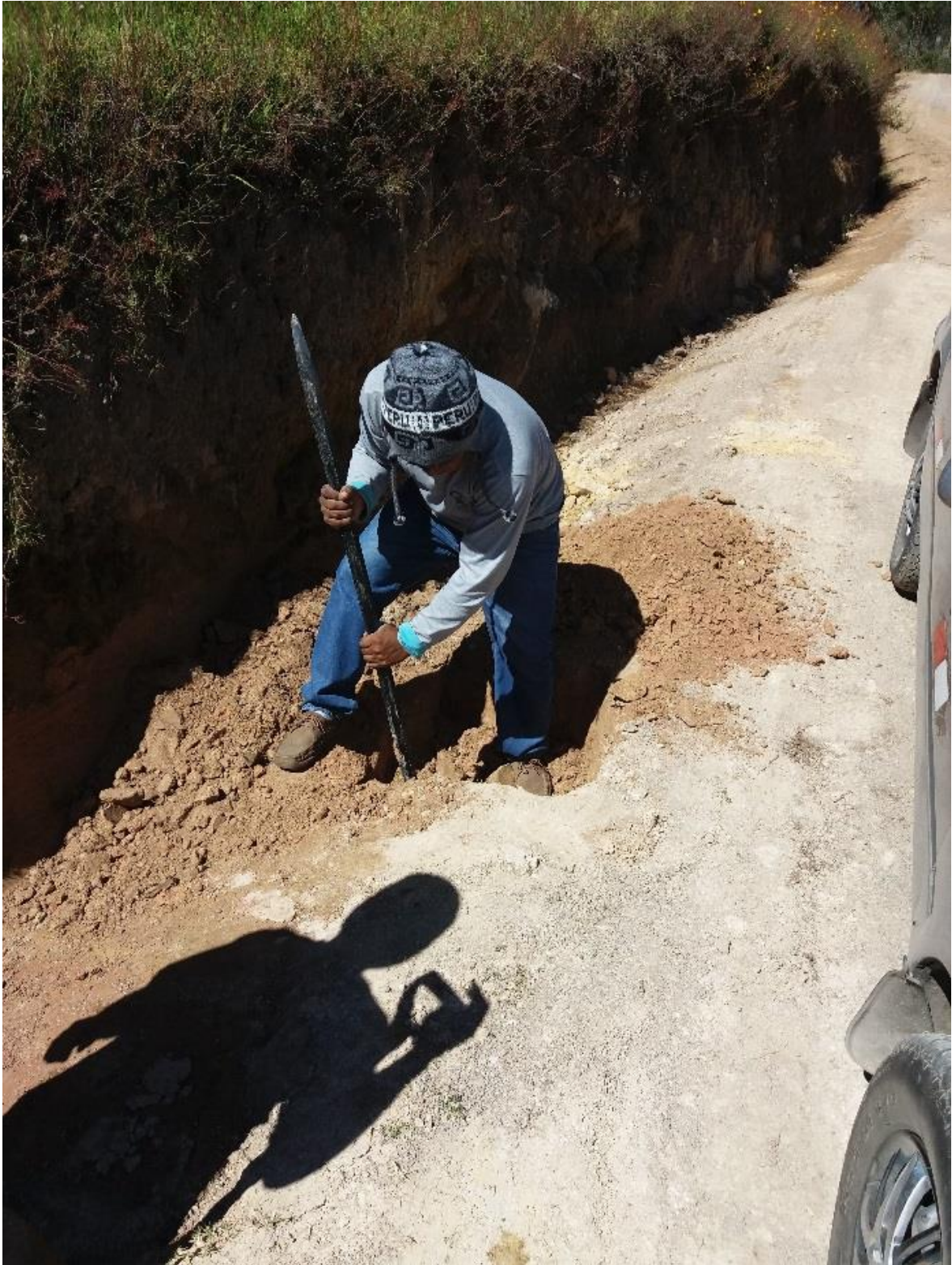
Figura 06. Excavación de pozos exploratorios (calicatas). Fuente: Elaboración propia.
