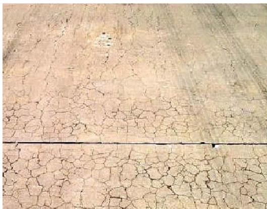
FIG. X2.21 Mapa de fisuras de severidad Baja
