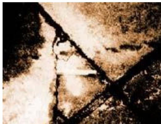
FIG. X2.35 Desprendimiento de esquina de severidad media
