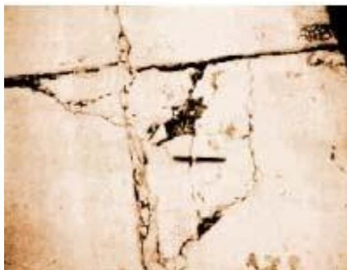
FIG. X2.36 Desprendimiento de esquina de severidad alta
