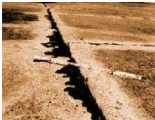
FIG. X2.25 Fallas de media severidad
