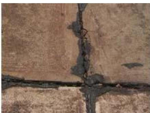
FIG. X2.31 Desprendimiento de baja severidad
