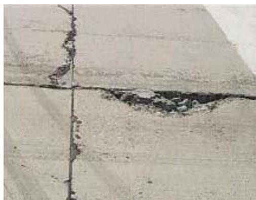
FIG. X2.33 Desprendimiento de alta severidad
