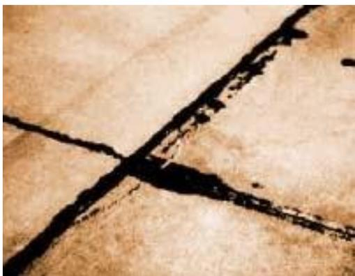
FIG. X2.34 Desprendimiento de esquina de severidad baja
