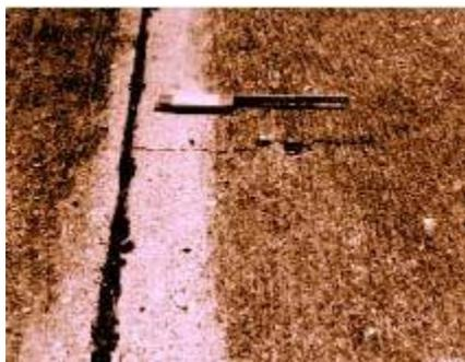
Fig. X2.30 Fisuras por contracción
