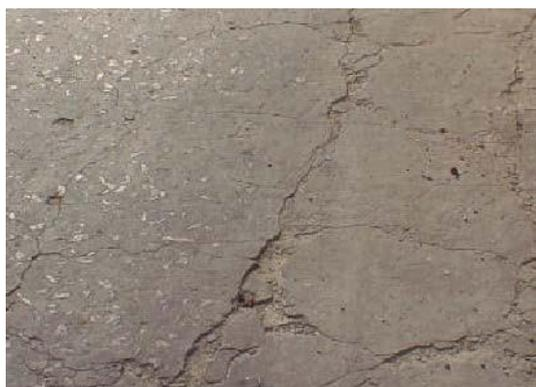
FIG. X2.22 Mapa de fisuras de severidad Media
