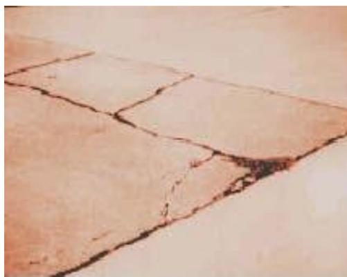
FIG. X2.27 Losa Cuarteada de baja severidad
