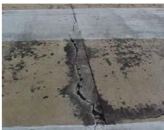
FIG. X2.32 Desprendimiento de media severidad
