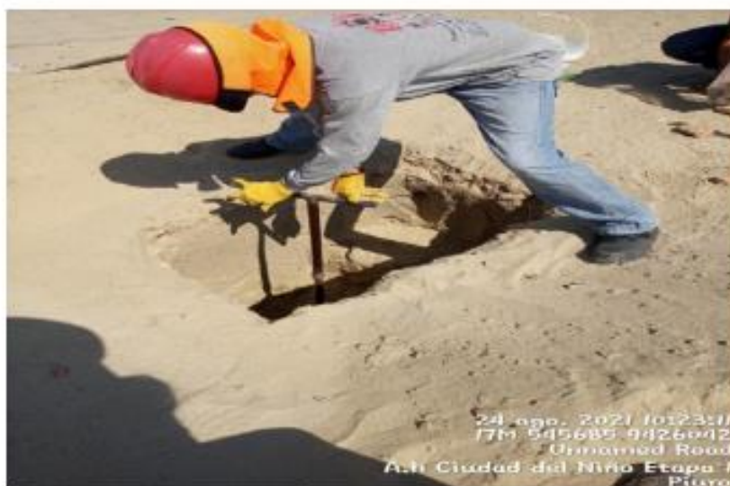
Fotografía 3: Extracción de muestras en la calicata 1, (perforación de 1.50m x 1.50m x 2m)
