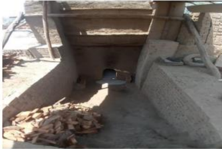
Fotografía 1: Horno artesanal de la ladrillera Valladolid
