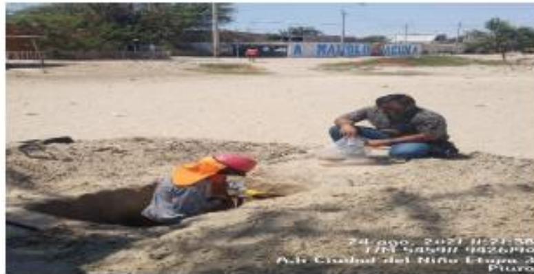
Fotografía 5: Extracción de muestras en la calicata 2
