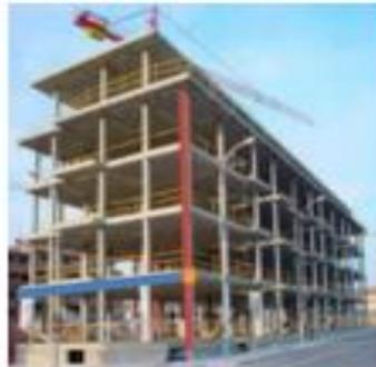
Sistema Aporticado : Son estructuras de concreto armado con la misma dosificación columnas, vigas peraltadas o chatas, unidas en zonas de confinamiento donde forman angula de 90° en el fondo parte superior y lados laterales.
