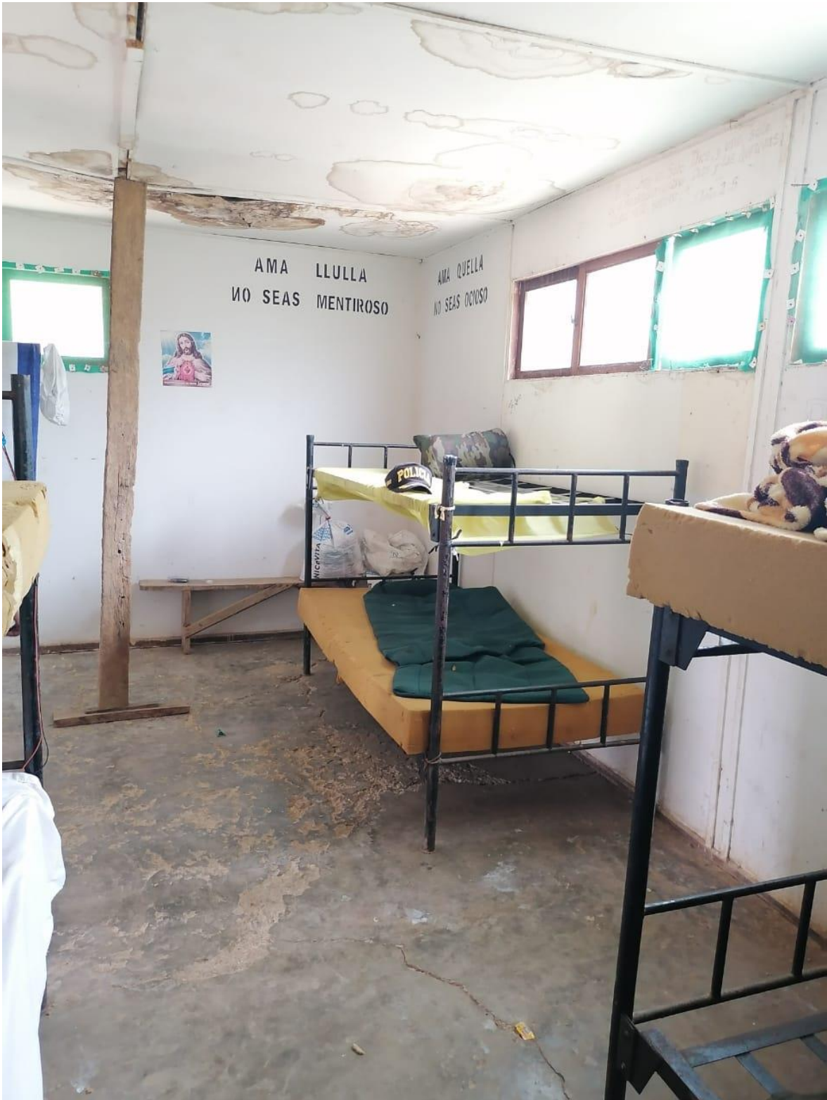
Dormitorio de los efectivos policiales del puesto de repliegue "Sargento Figueroa"
