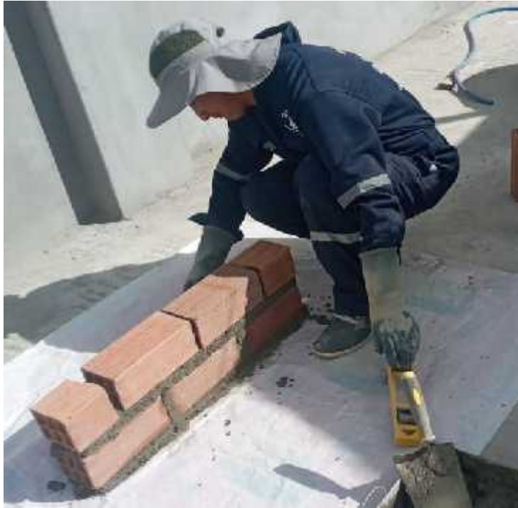
13) Asentado de muro con mortero + aditivo
