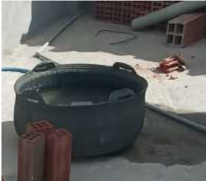
10) humedecimiento de ladrillos
