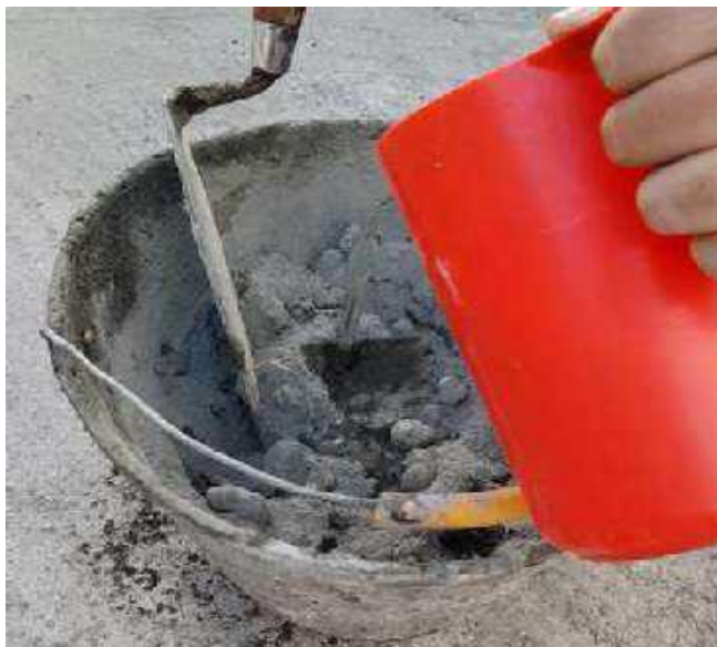
fotografía 37: preparación de mezcla para mortero adicionándole aditivo plastificante.
