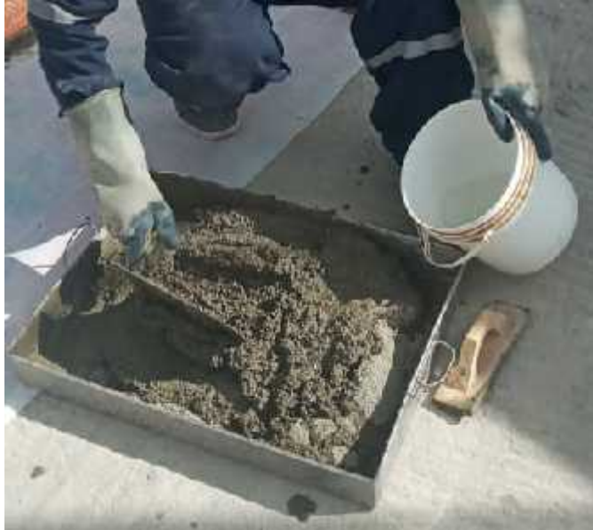
fotografía 36: preparación de mezcla para mortero
