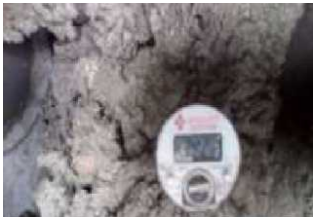
Fotografía 26: Control de temperatura de la mezcla
