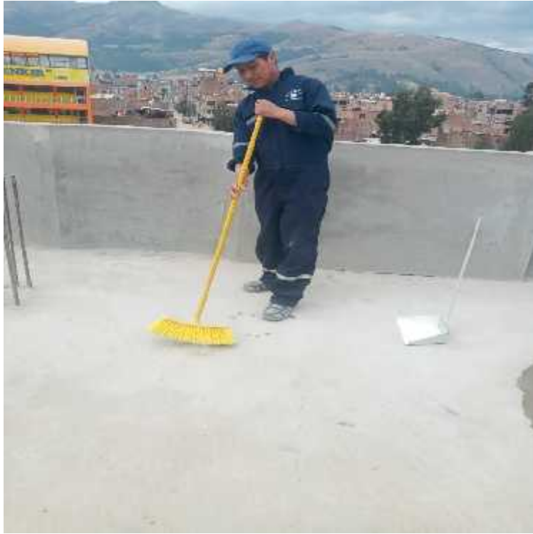
9) Limpieza del terreno para posterior asentado de muros
