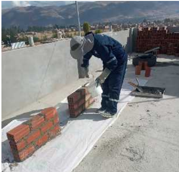
fotografía 39: proceso de curado de muros.
