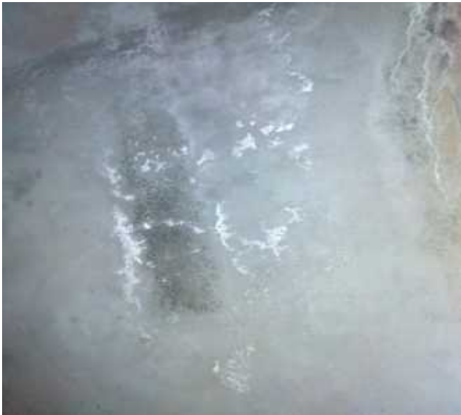
Fotografía 3: eflorescencia primaria.
