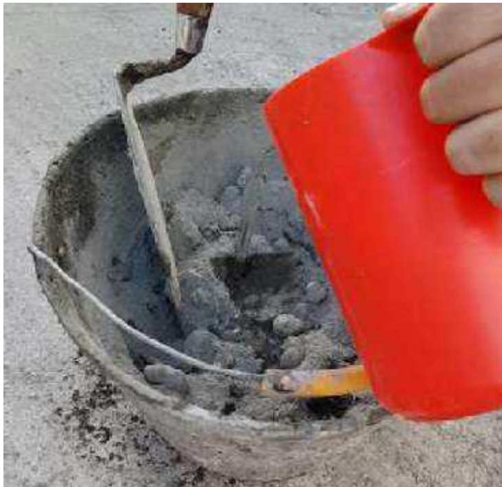
12) Mezcla de mortero adicionándole plastificante.
