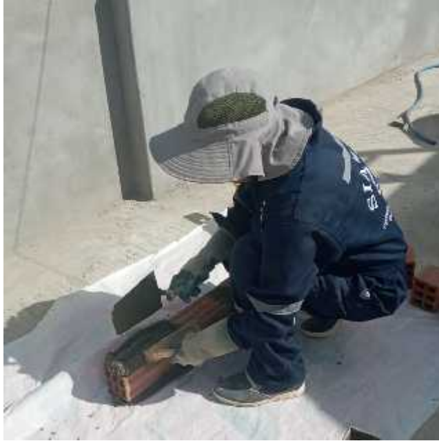
fotografía 38: proceso de asentado de ladrillos.
