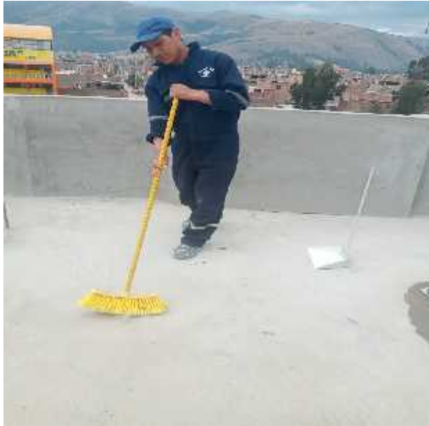
fotografía 34: limpieza y eliminación de impurezas de la superficie
