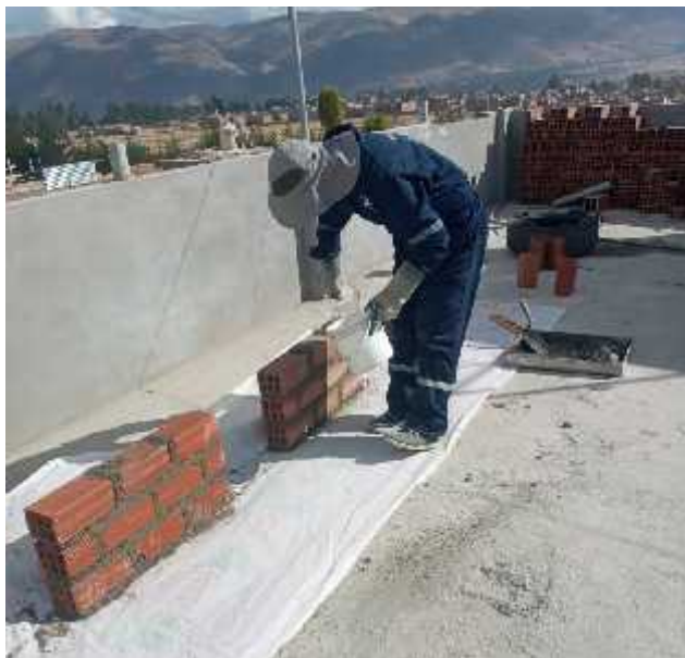
fotografía 39: proceso de curado de muros.
