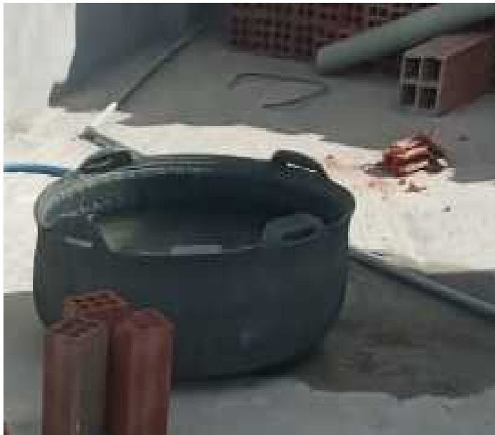
10) humedecimiento de ladrillos
