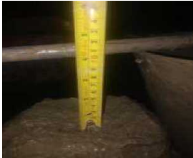
fotografía 25: medida del asentamiento del concreto
