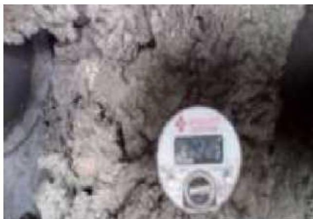
Fotografía 26: Control de temperatura de la mezcla
