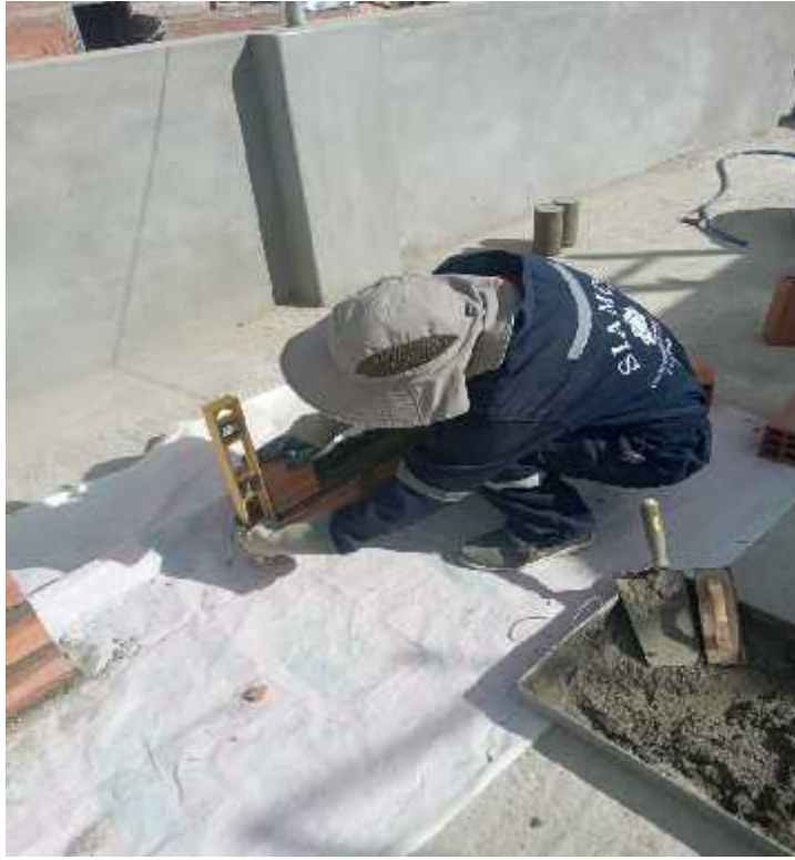
11) Asentado de muro con mortero sin plastificante
