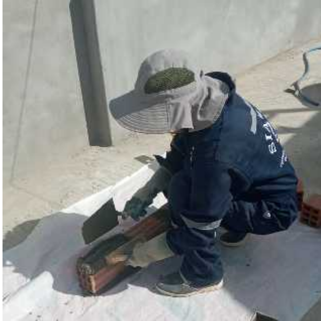
fotografía 38: proceso de asentado de ladrillos.
