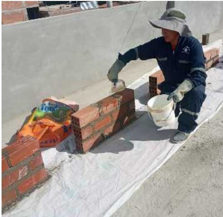
14) Curado de muros.
