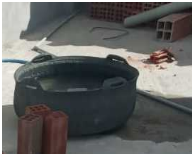
fotografía 35: humedecimiento de ladrillos
