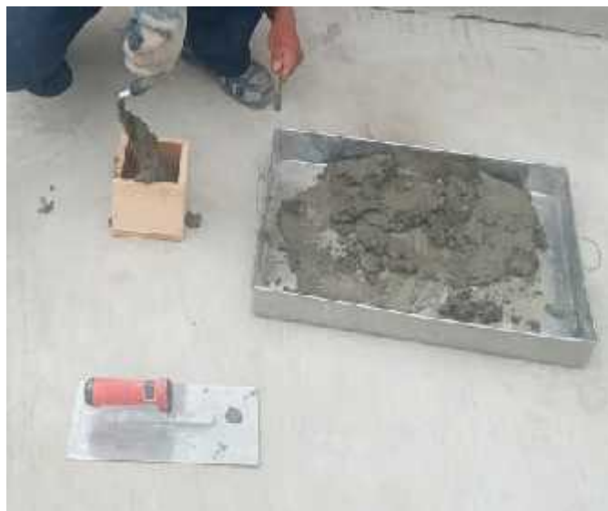
Fotografía 29: llenado de cubos de concreto
