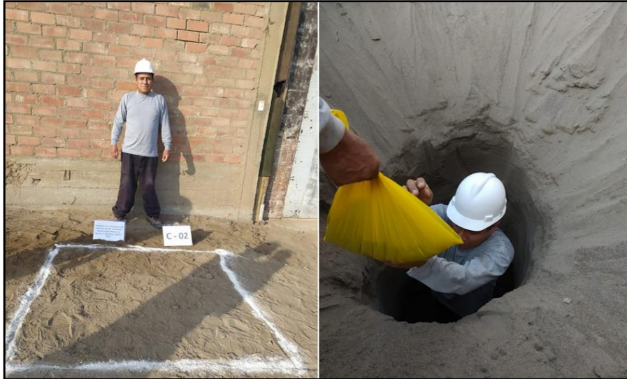
Figura 18. Extracción de muestras de calicata 02.
