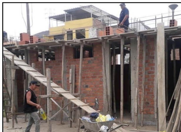
Figura 6. Construcción de losa aligerada.
