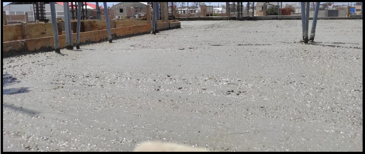
Figura 1: Foto panorámica de la problemática
