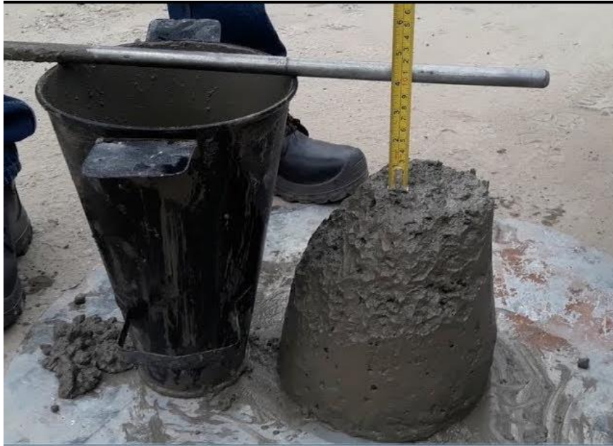
Ensayo del SLUMP
