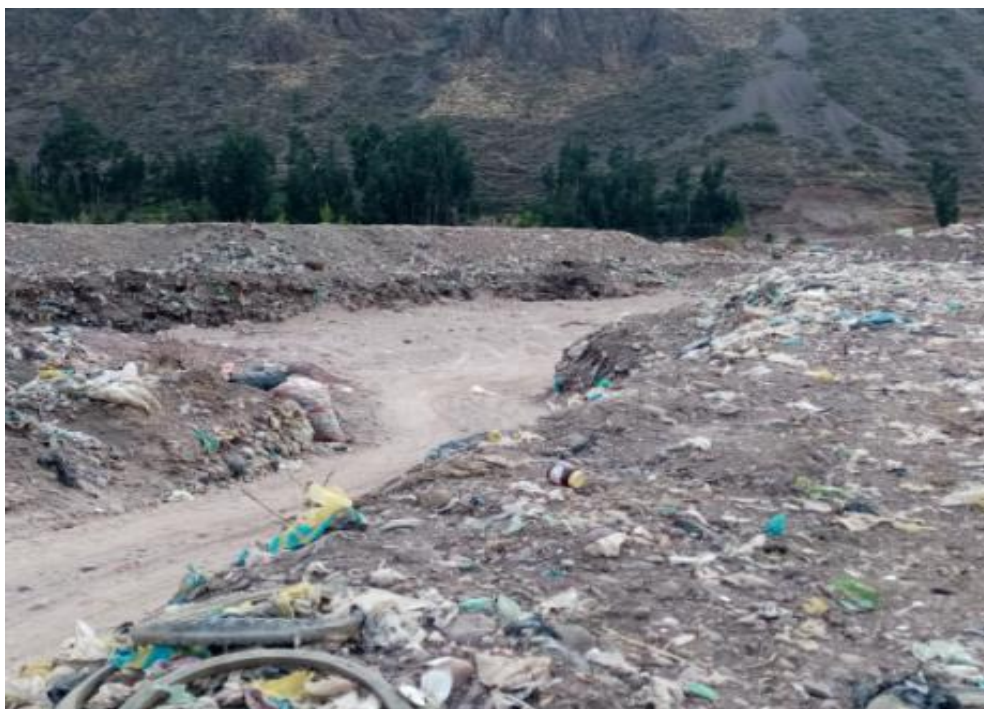
Figura 5. Camino interno al área de confinamiento
