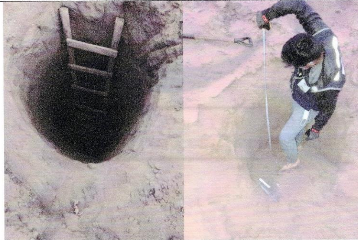
Excavación de Calicatas
