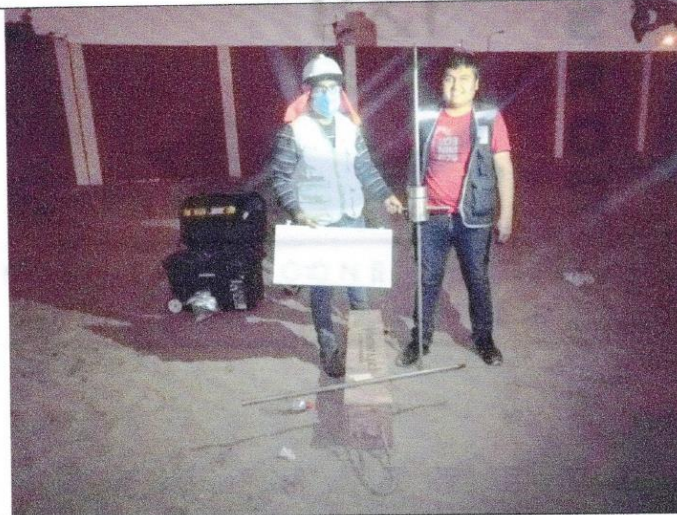
Ejecución de Ensayo de Campo - DPL
