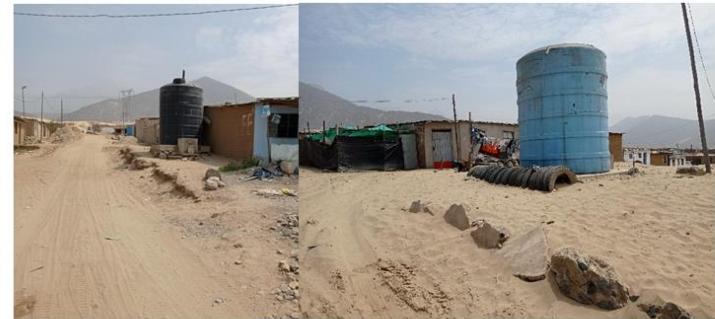
Provisión de agua potable a través de llenado de tanques por camión cisterna
