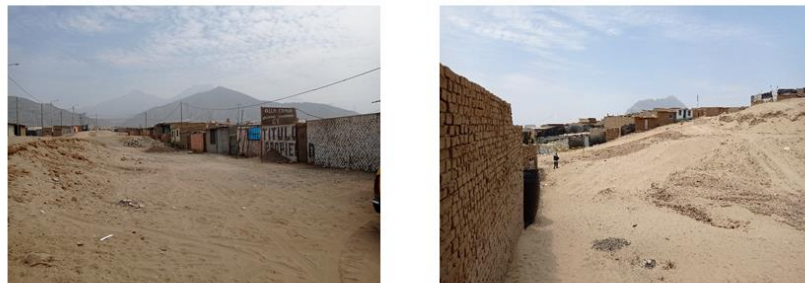
Mal estado de conservación de viviendas, alto pendiente de vías y suelo accidentado
