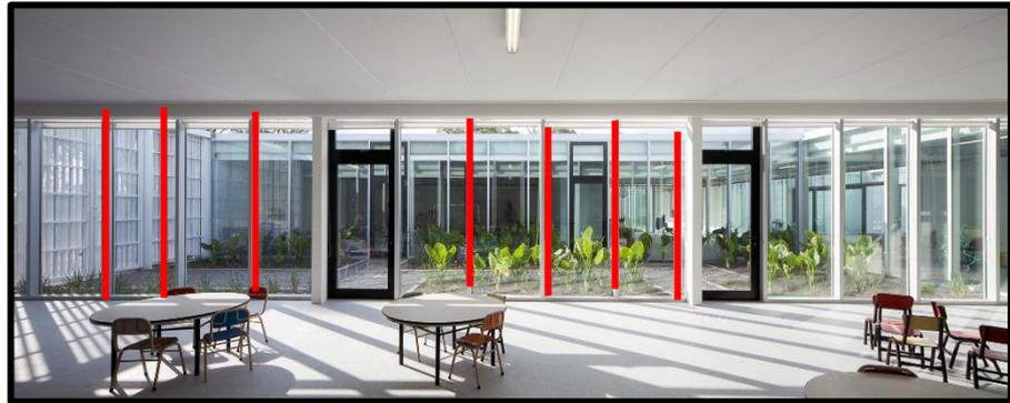
Figura 105: Apreciación de la carpintería de aluminio con mamparas de vidrio
