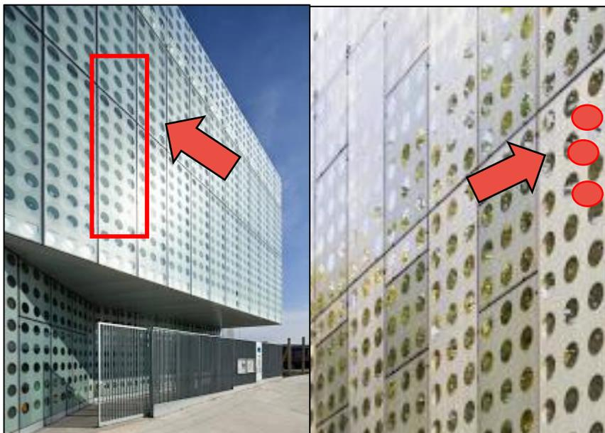
**Figura 99: Detalle de la fachada, piel transparente y patrón de círculos**
