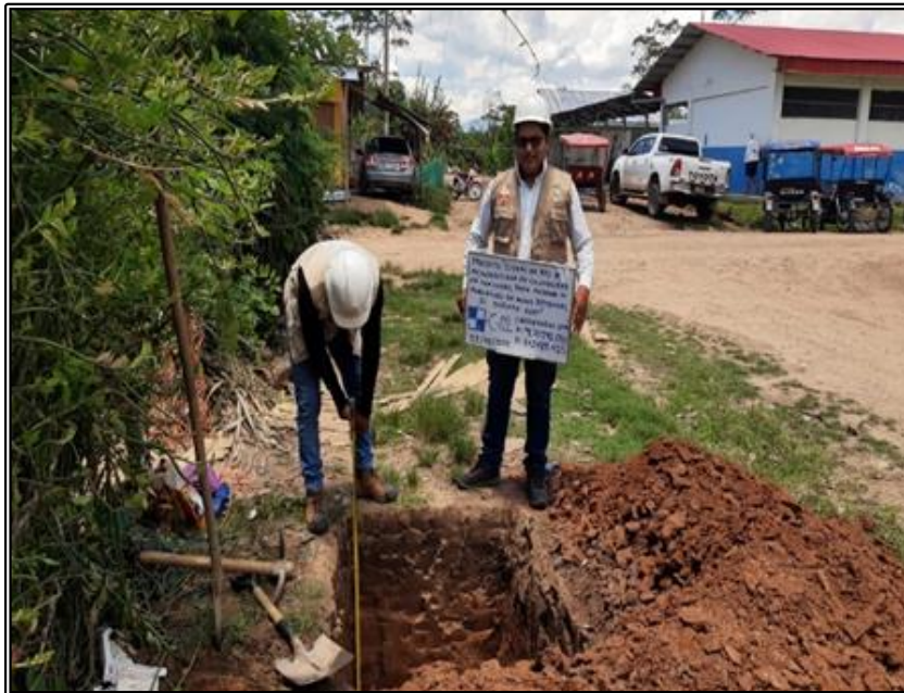
Figura 10. Vista de medidas correspondientes de la calicata N° 02
