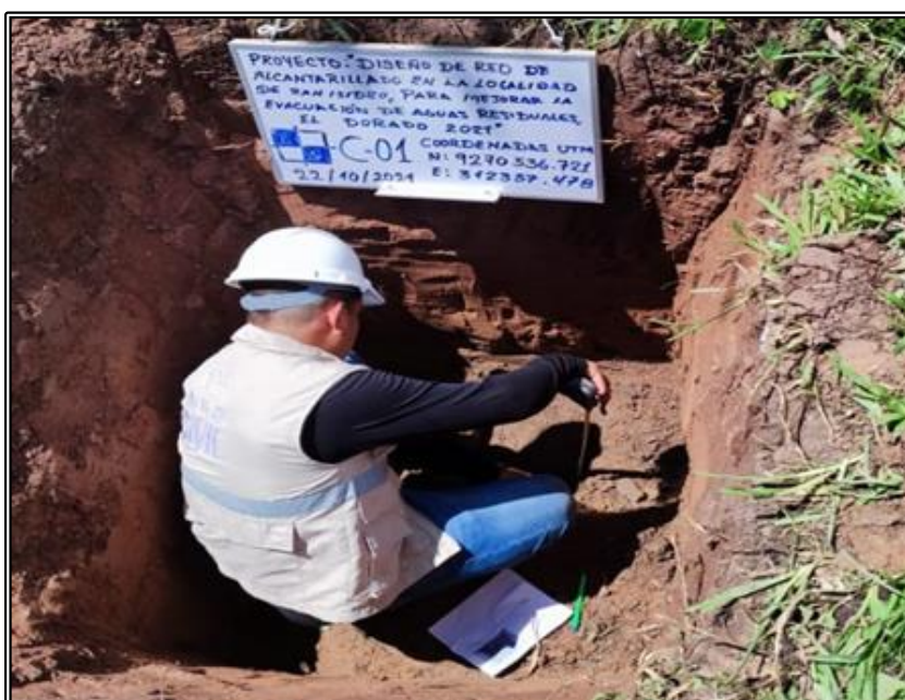
Figura 8. Vista de medidas correspondientes de la calicata N° 01
