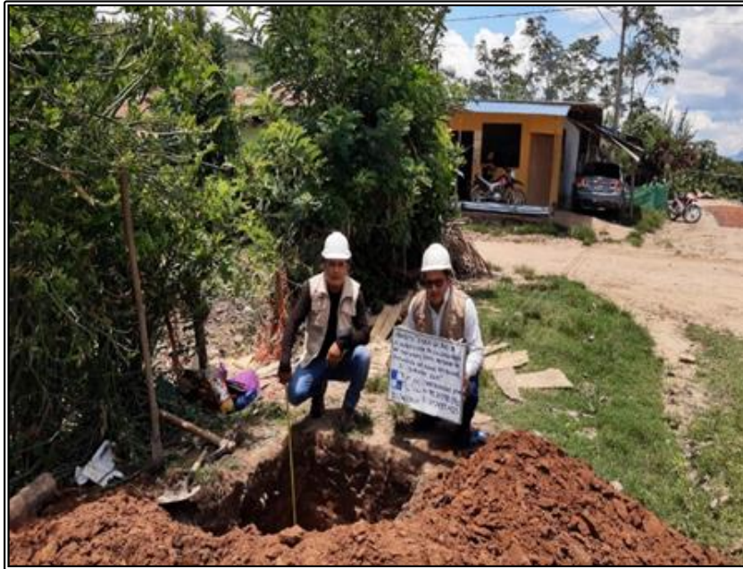
Figura 9. Vista preliminar de la calicata N° 02
