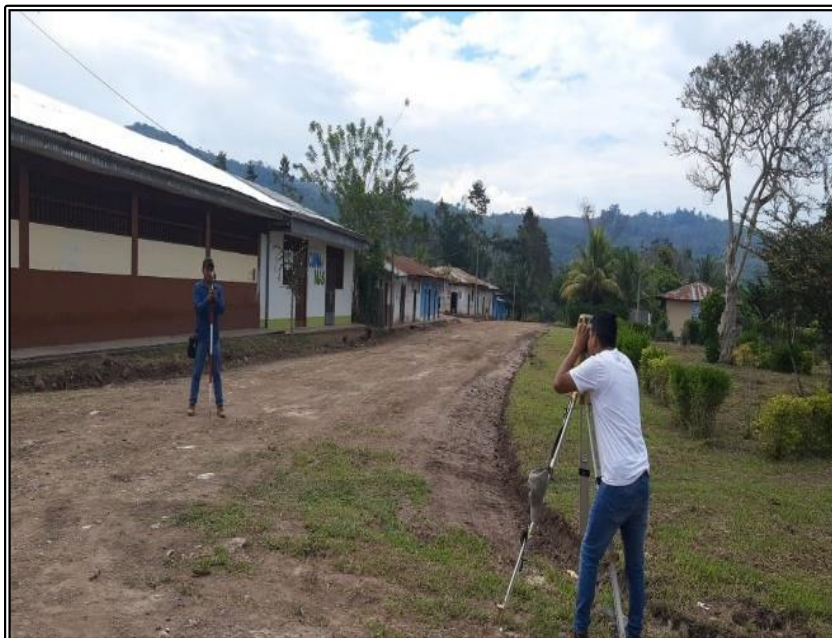
Figura 4. Levantamiento topográfico en el Jr. Giba R. y Libertad C-01
