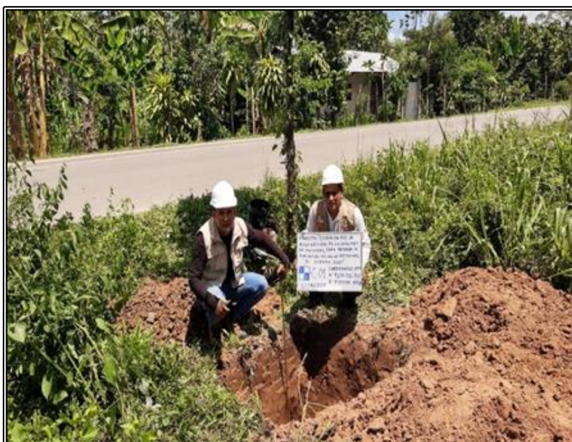
Figura 7. Vista preliminar de la calicata N° 01
