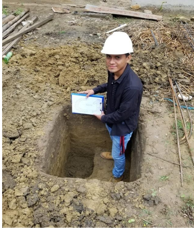
Figura 8: Vista de calicata por el tesista 1 para el EMS
