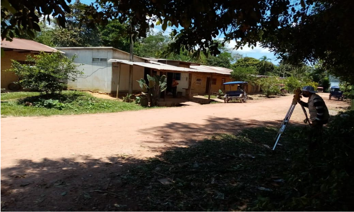
Figura 4: Levantamiento topográfico del Jr. Sargento Lores frente al terreno
