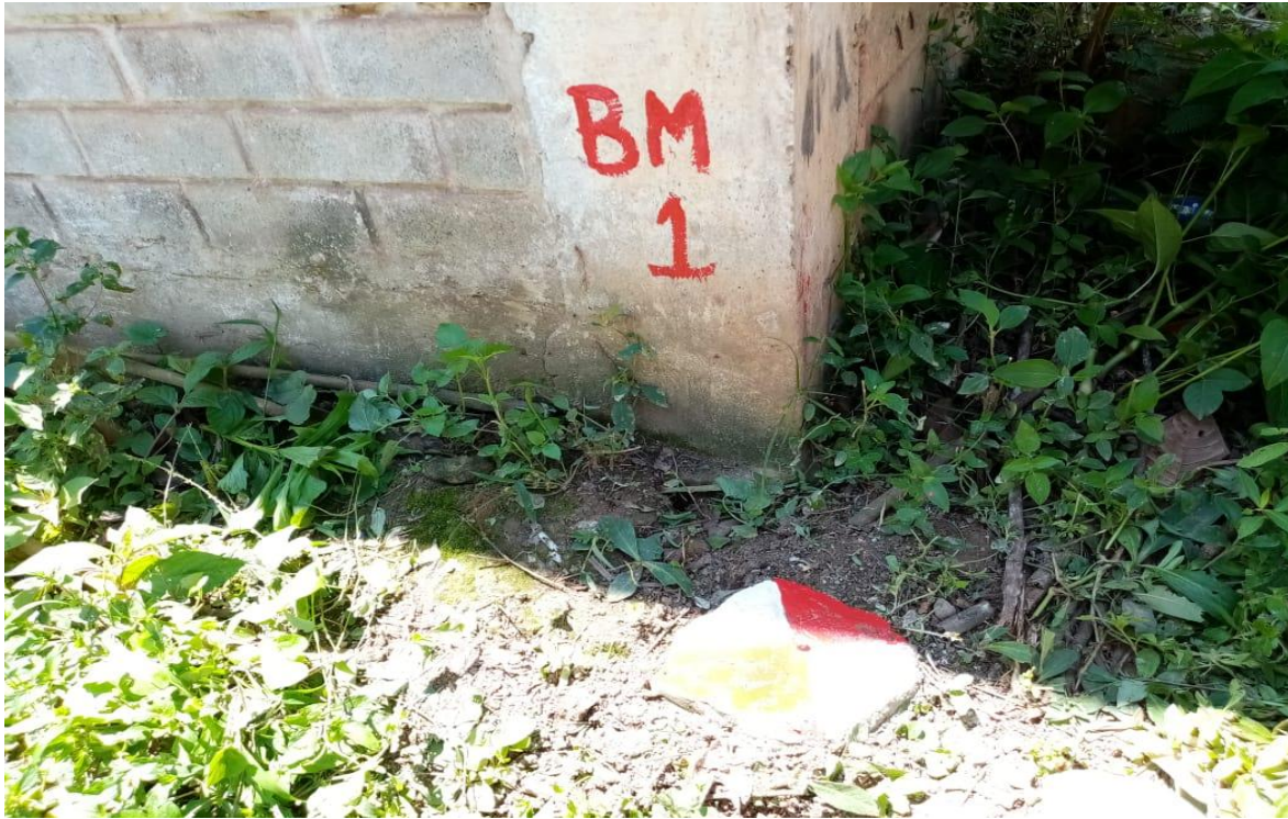
Figura 6: Ubicación del BM 01 con hito de concreto y núcleo de acero
