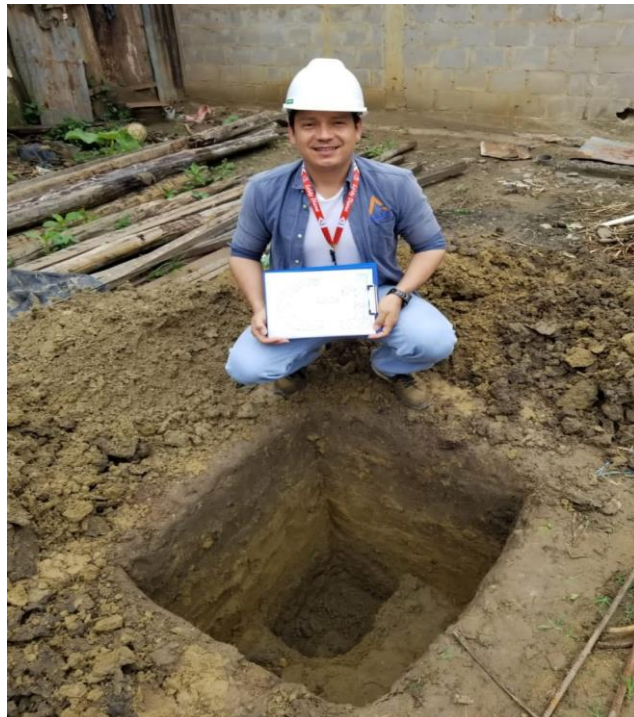
Figura 8: Vista de calicata por el tesista 1 para el EMS
