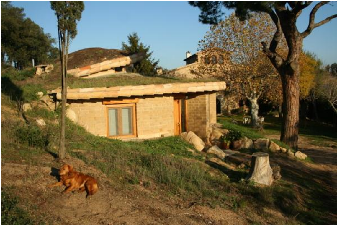
Nota: Construcciones con materiales que se relacionan con el entorno natural
