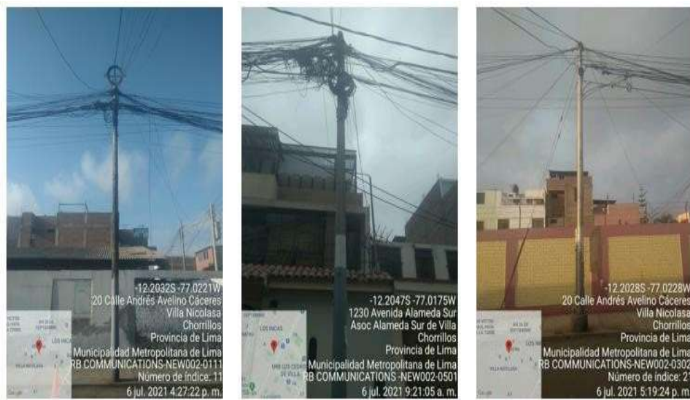
Figura 27: Detalles de infraestructura postes.
