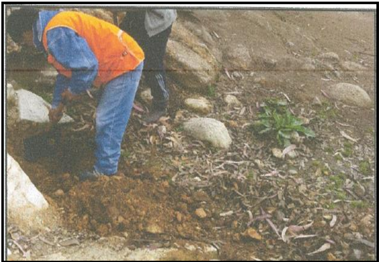
VISTA DE CALICATA EN EL PROYECTO
