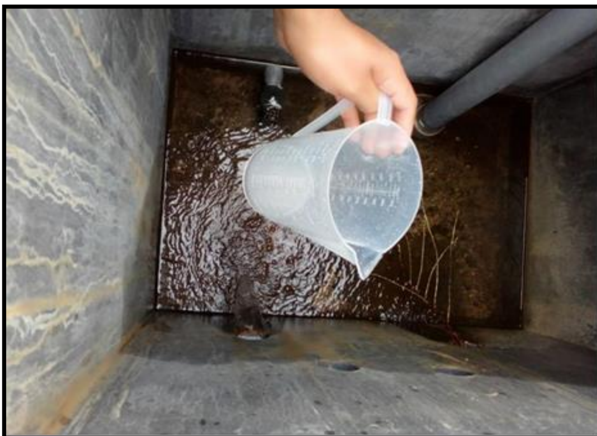
VISTA DE PROCESO DE MEDICIÓN DE CAUDAL - MANANTIAL HUINCUYPUQUIO
