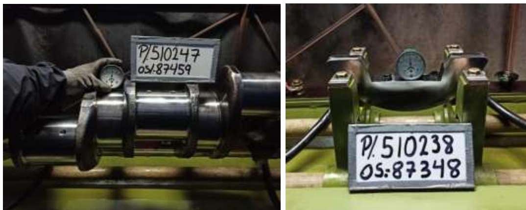
Figura 30. Verificación de degmanetizado
