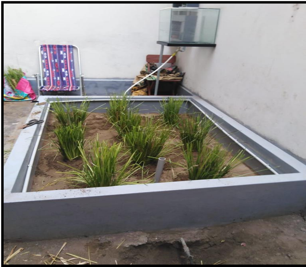
Siembra de la planta vetiver en el humedal artificial de flujo vertical
