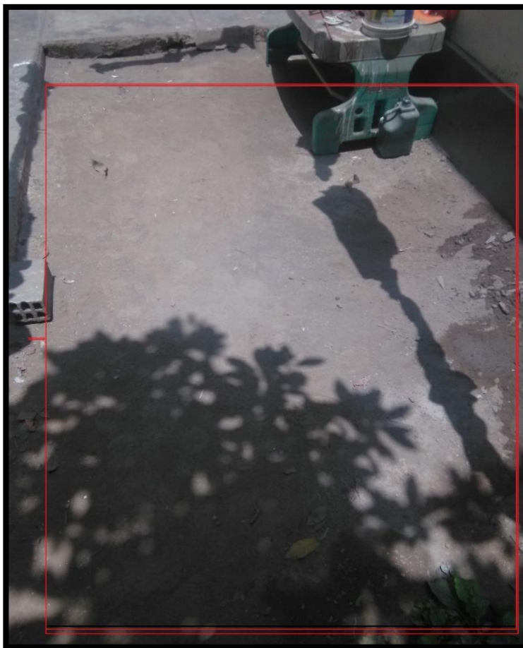
Figura 8: Lugar donde se realizará la construcción
