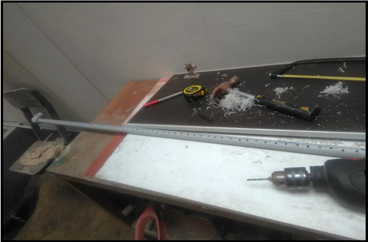
Perforación de la red de tubos del humedal artificial de flujo vertical.
