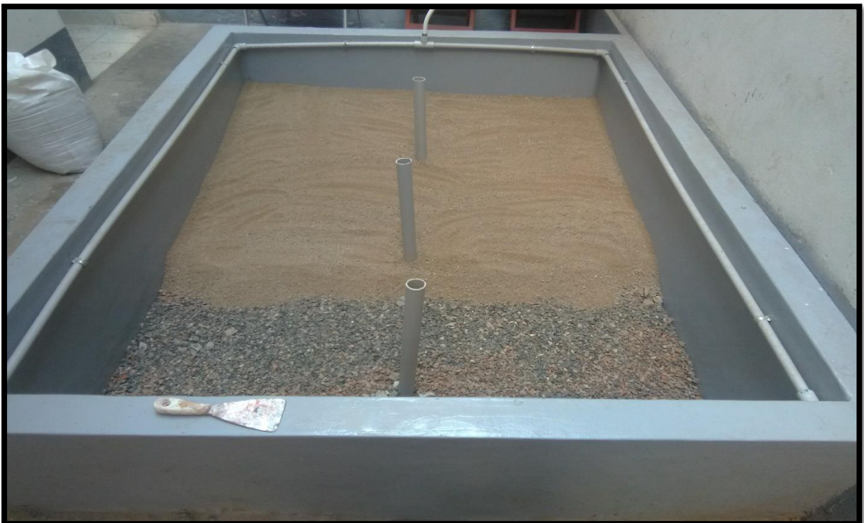
Colocación de la arena fina y gruesa en el humedal artificial.
