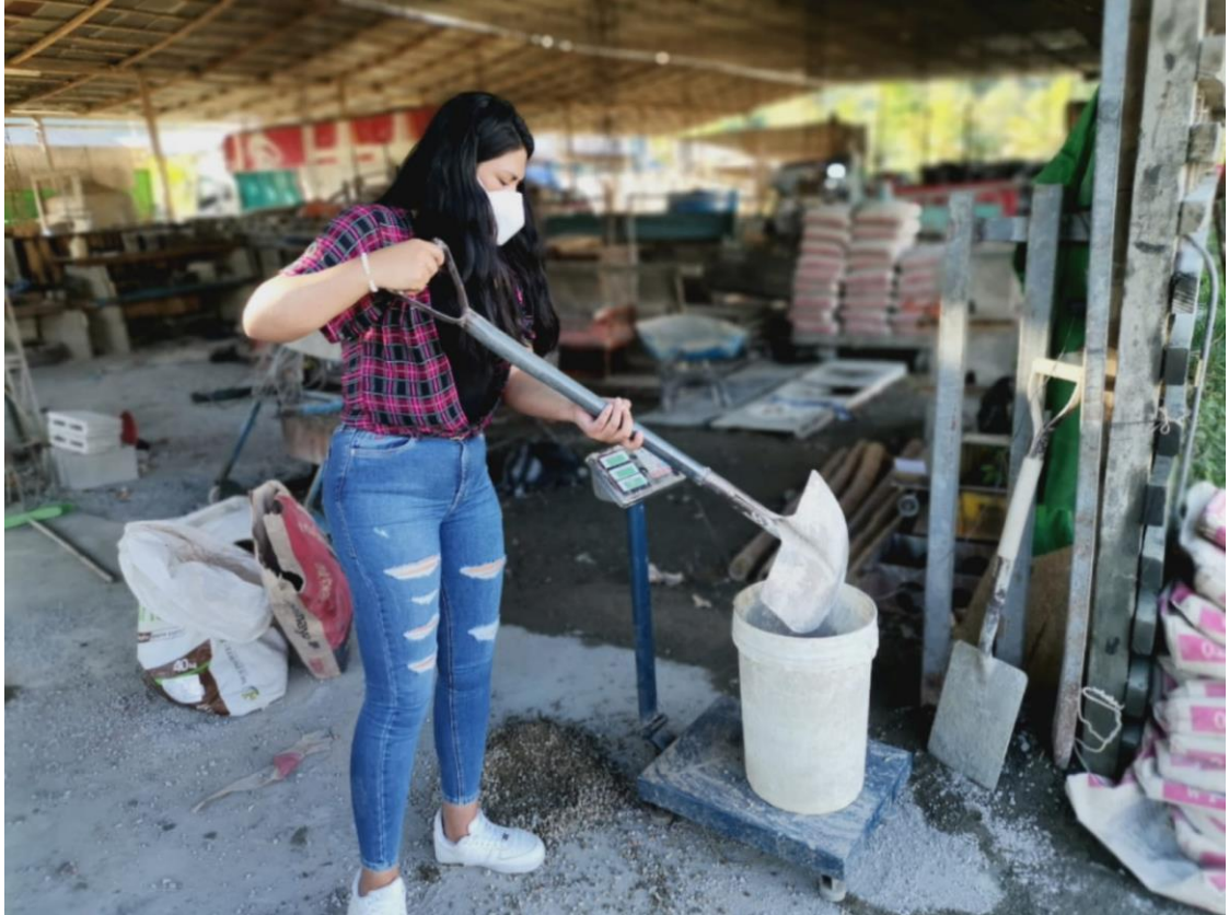
Figura 9 Pesado de las dosificaciones de cemento para la mezcla
