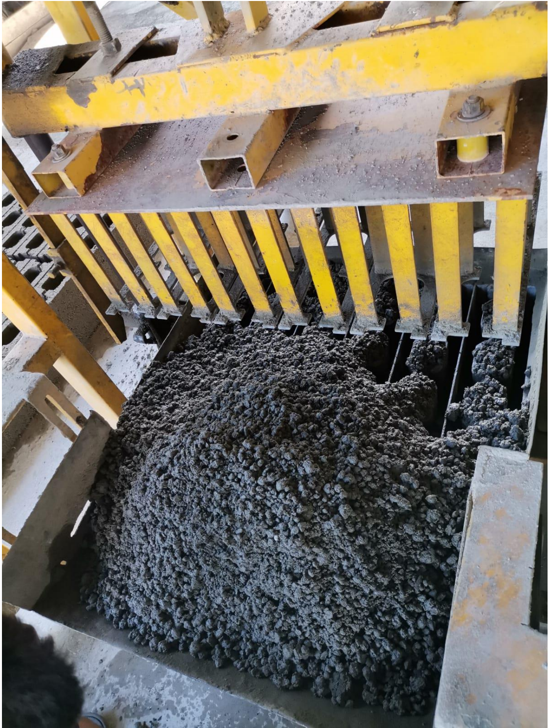
Figura 17: concreto en tolva de ladrillera
