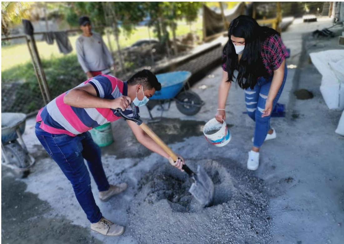
Figura 14: Producción de concreto para ladrillos 20% desmonte
