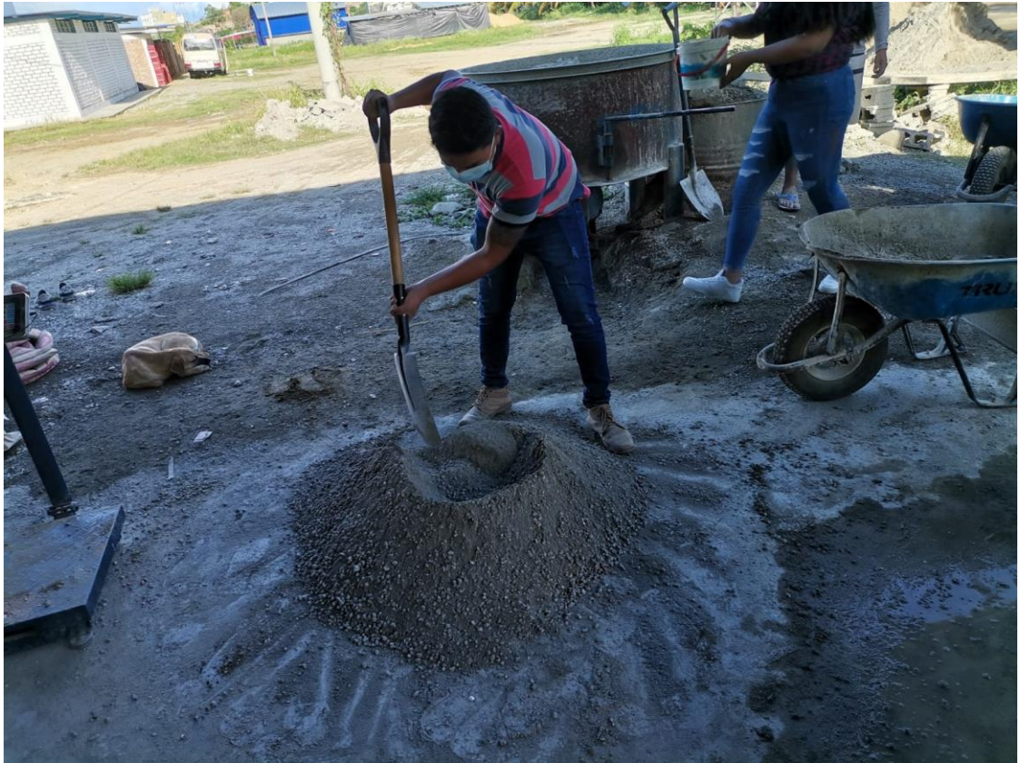
Figura 15: incorporación de agua a la mezcla y mezclado 35% desmante
