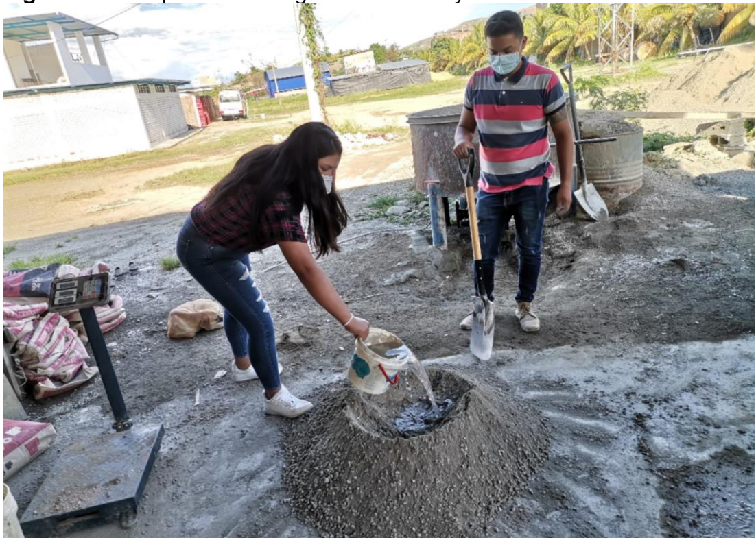
Figura 16: incorporación de agua a la mezcla y mezclado 50% desmante
