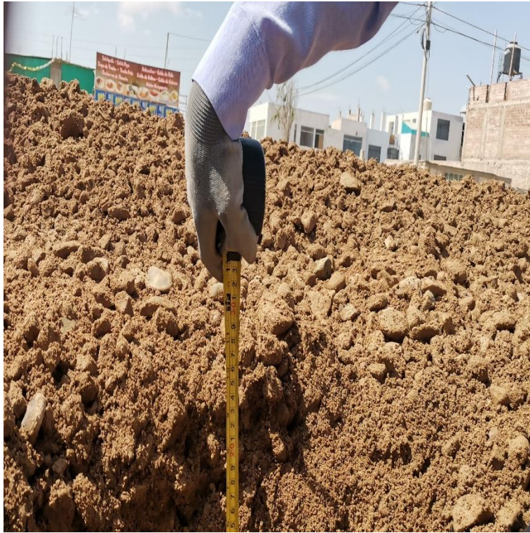
Figura 45: Obtención de espesor de capas del pavimento.
