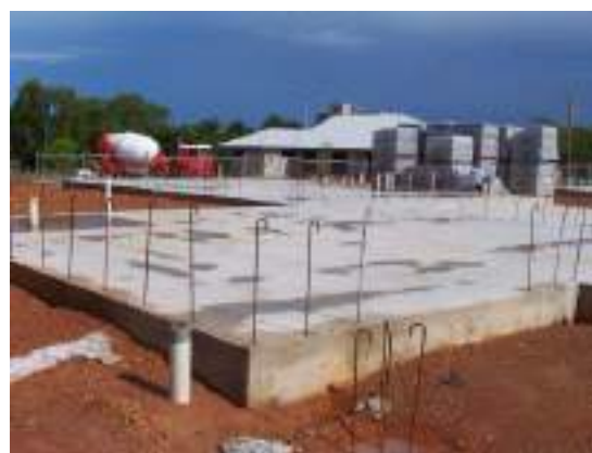
Construcción sobre plataformas
