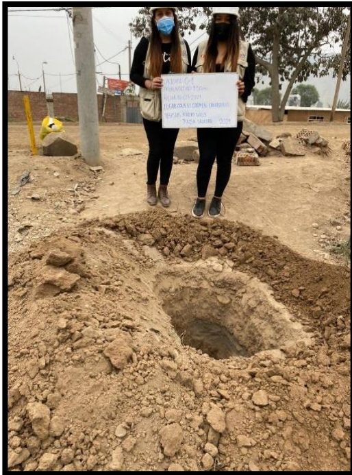
FOTO5: Extracción de la muestra (Calicata 3)
