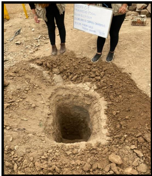
FOTO3: Extracción de la muestra (Calicata 1)
