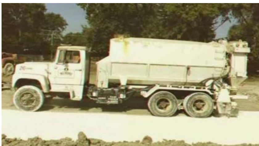
Figura 3. Uso de la Cal seca con aplicación mecánica.
