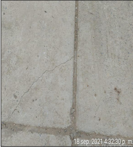
Fografía 01 y 02: fallas de grietas de esquina.
