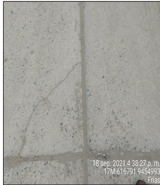
Fografía 01 y 02: fallas de grietas de esquina.
