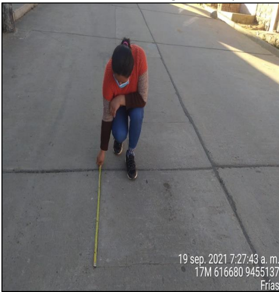
Fotografía: 07 y 08: medicion de las fallas
