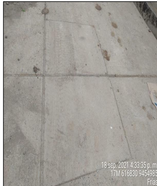
Fografía 01 y 02: fallas de grietas de esquina.
