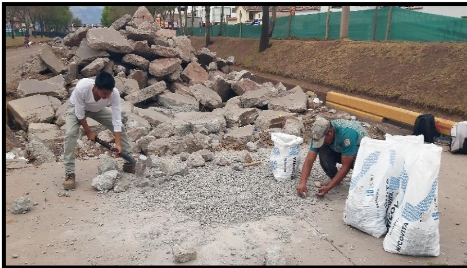
Figura 04. Proceso de chancado del agregado
