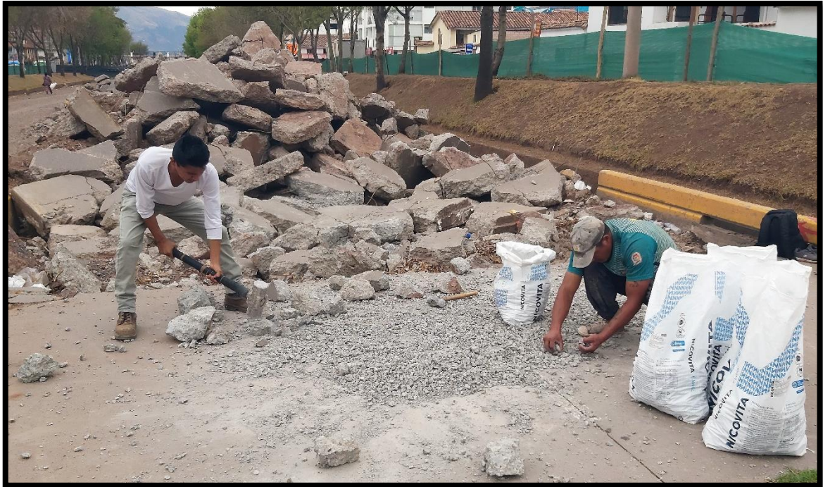
Extracción y triturado manual del material reciclado.
