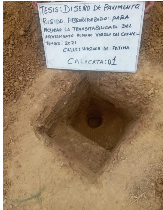
Figura 15. Realización de calicata C1
