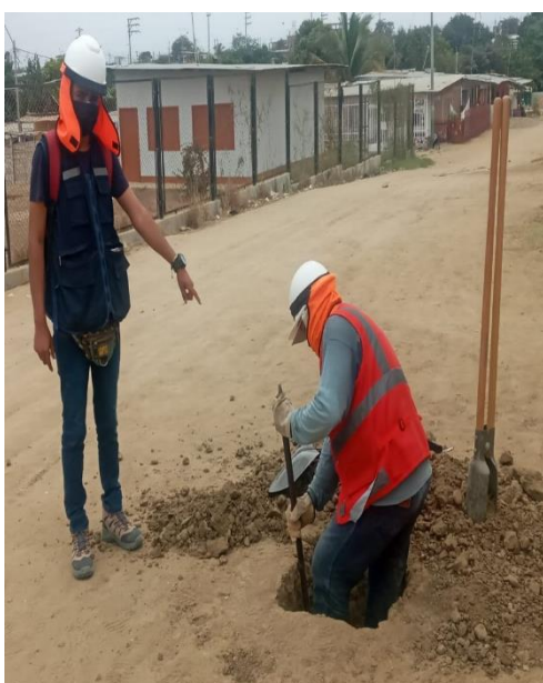
Figura 18. Realización de calicata C3
