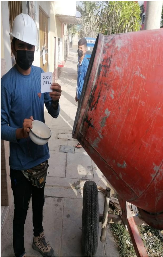
Figura 90. Aplicación de fibra de acero al 2.5 %.
