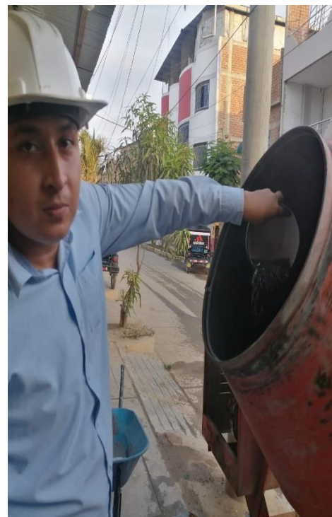
Figura 91. Aplicación de fibra de acero al 5 %.
