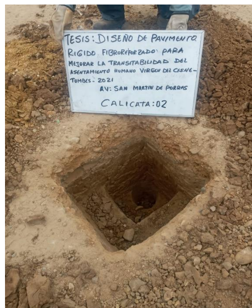
Figura 17. Realización de calicata C2
