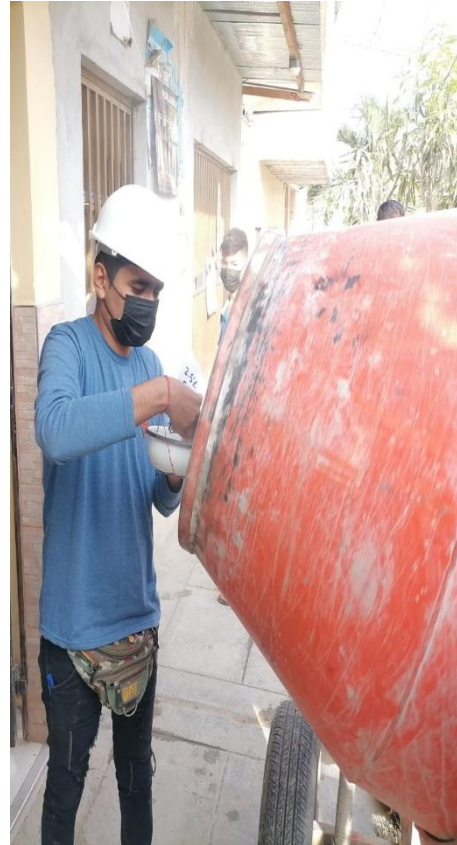
Figura 89: Aplicación de fibra de acero al 2.5 %.
