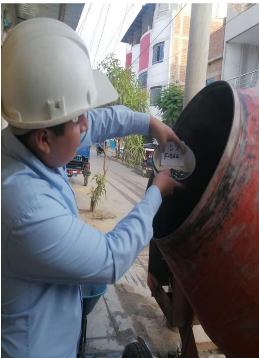
Figura 92. Aplicación de fibra de acero al 5 %.
