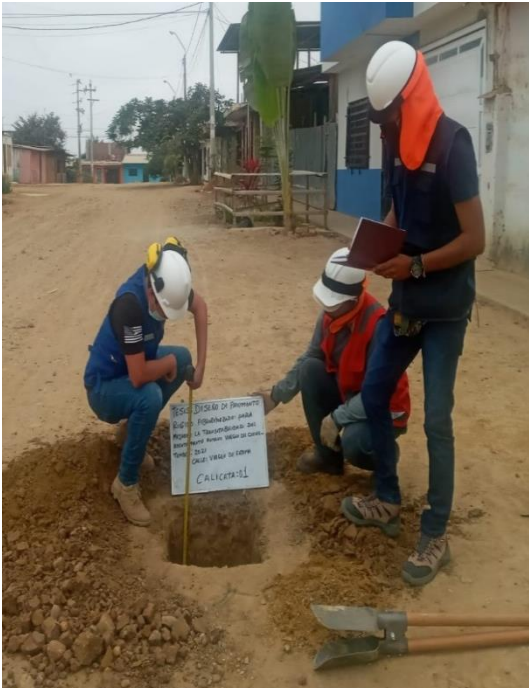
Figura 14. Realización de calicata C1
