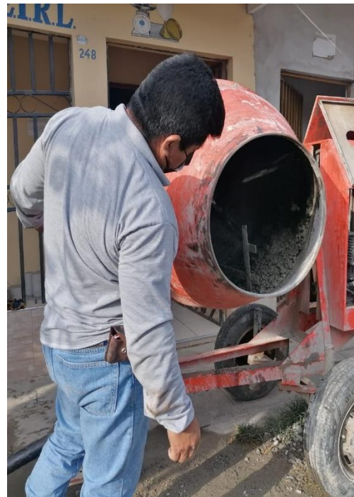
Figura 87. Mezclado del concreto.
