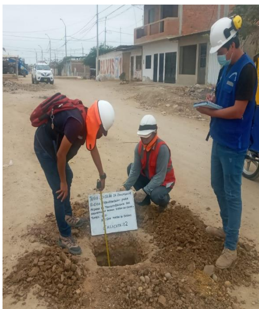
Figura 16. Realización de calicata C2
