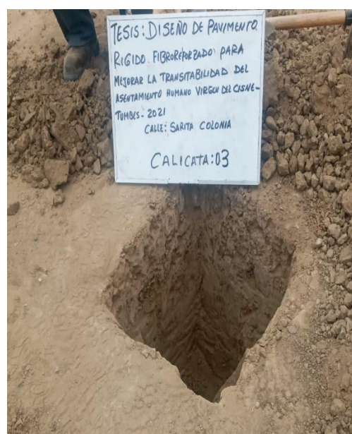
Figura 19. Realización de calicata C3
