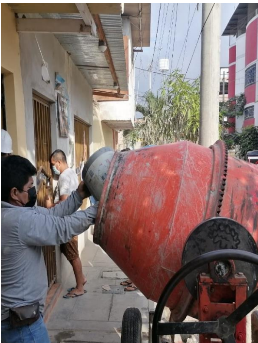
Figura 88. Mezclado del concreto.
