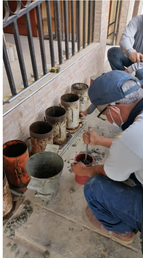
Figura 100. Elaboración de probetas con el concreto patrón – F'c = 210 \text{ kg/cm}^2 .
