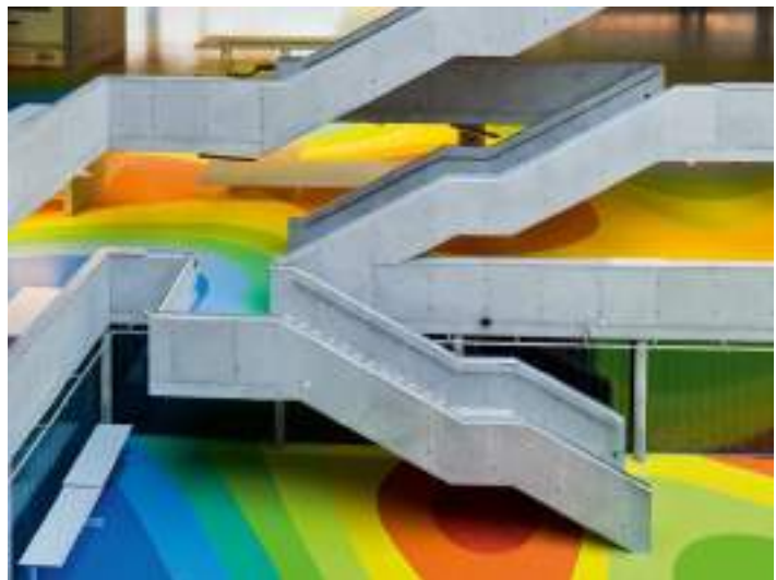
Figura 123: Revestimiento de caucho
