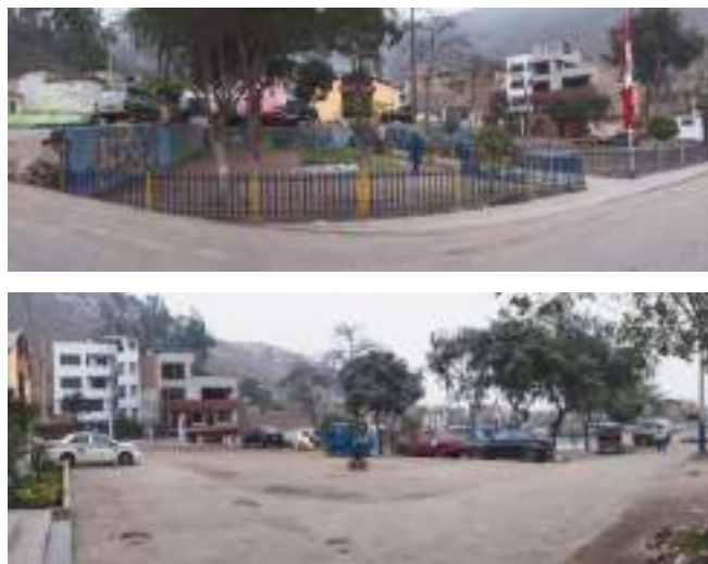
Figura 45: Estado previo a la intervención del parque Villa Clorinda. Javier Vera Cubas
