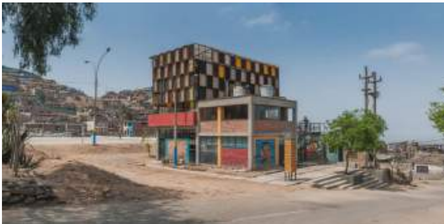
Figura 16: Comedor San Martín después de la remodelación
