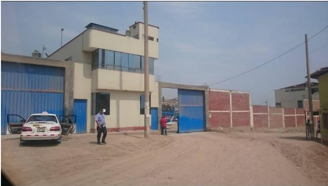
Ilustración 2 Vista del ingreso a la empresa
