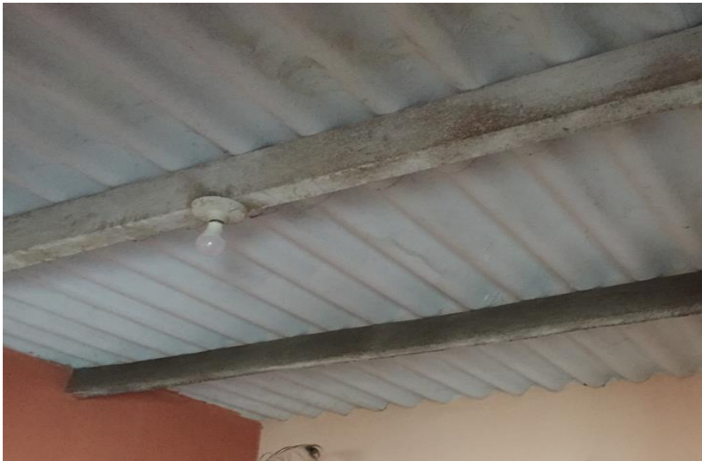
Título: Foto del interior de la vivienda con material fibrocemento predominante en el techo.
