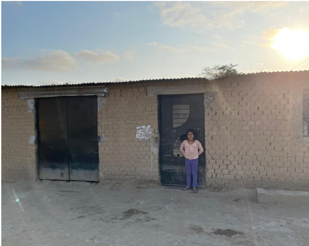
Título: Viviendas con material predominante adobe del Sector La Arenita parte Alta.
