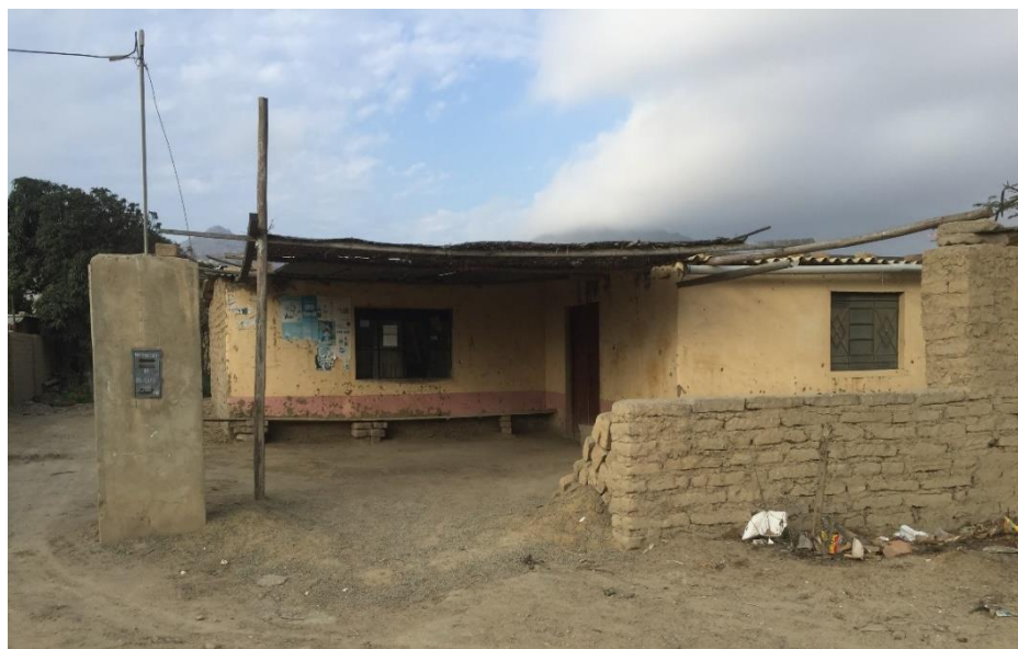
Título: Viviendas con material predominante adobe del Sector La Arenita parte Alta.
