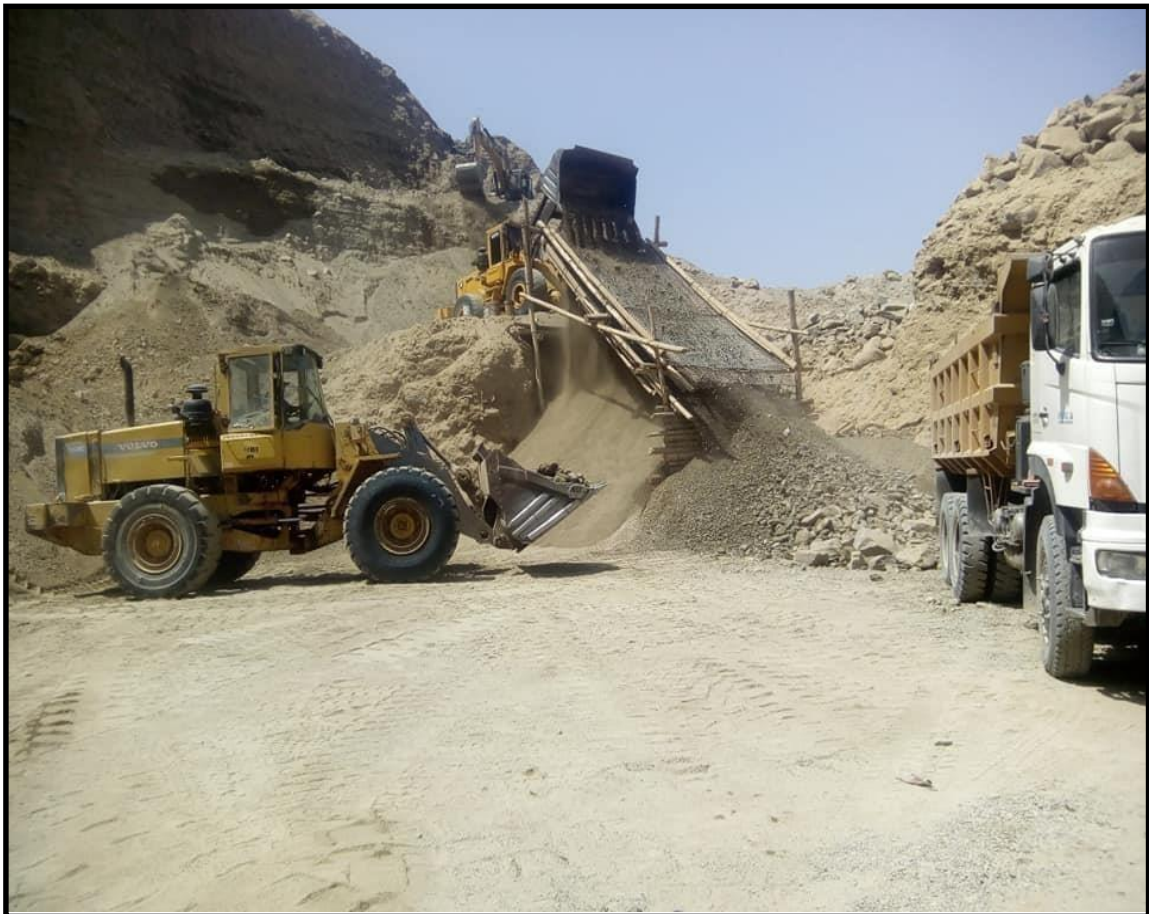
Figura 5. Zona de extracción de agregados – Cantera Huamani - Trapiche
