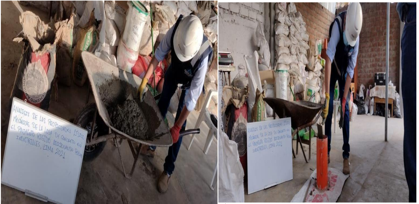
Figura 40: preparación y vaciado en el molde metálico. Fuente: elaboración propia
