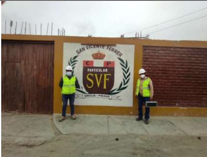
Fotografía 1. Fachada del colegio San Vicente de Ferrer - Chincha
