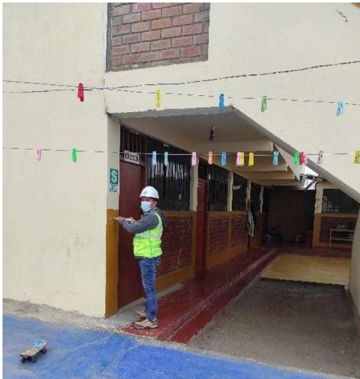
Fotografía 12. Ensayo de esclerometría C-2
