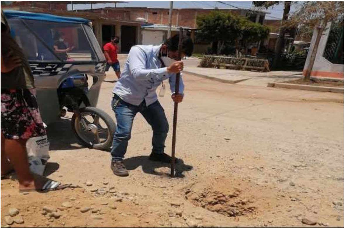
Fotografía 71: Excavación de calicatas
