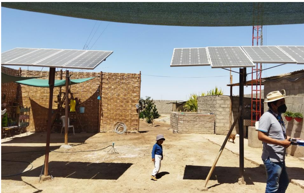
Reconocimiento de instalación de paneles fotovoltaicos
