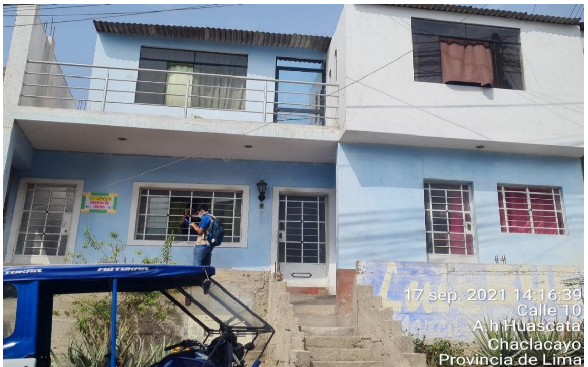
Figura 6. Vivienda de Concreto Armado
