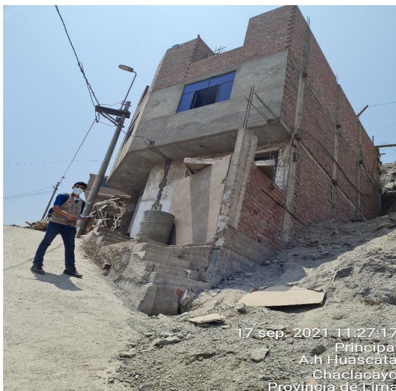
Figura 1. Vivienda de albañilería en pendiente pronunciada.
