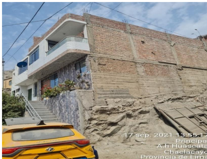
Figura 7. Vivienda de Albañilería
