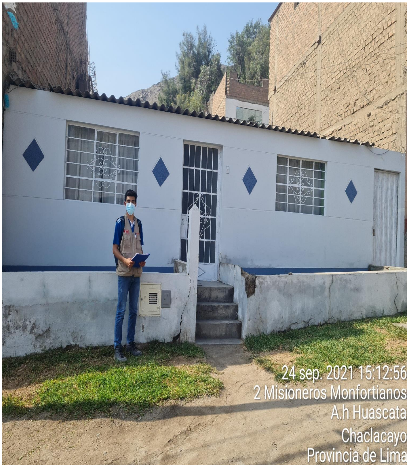
Figura 16. Vulnerabilidad Sísmica en Vivienda de Albañilería en Ladera de Pendiente Media
