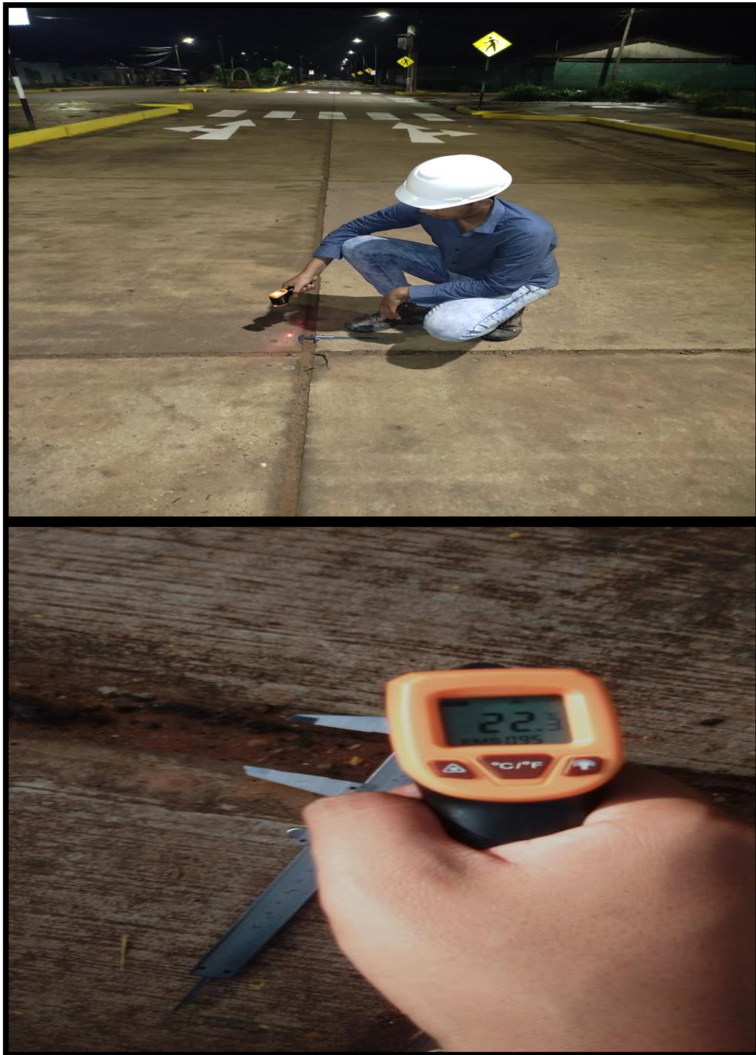
Figura N ° 18. recolección de datos junta longitudinal tercer tramo noche
