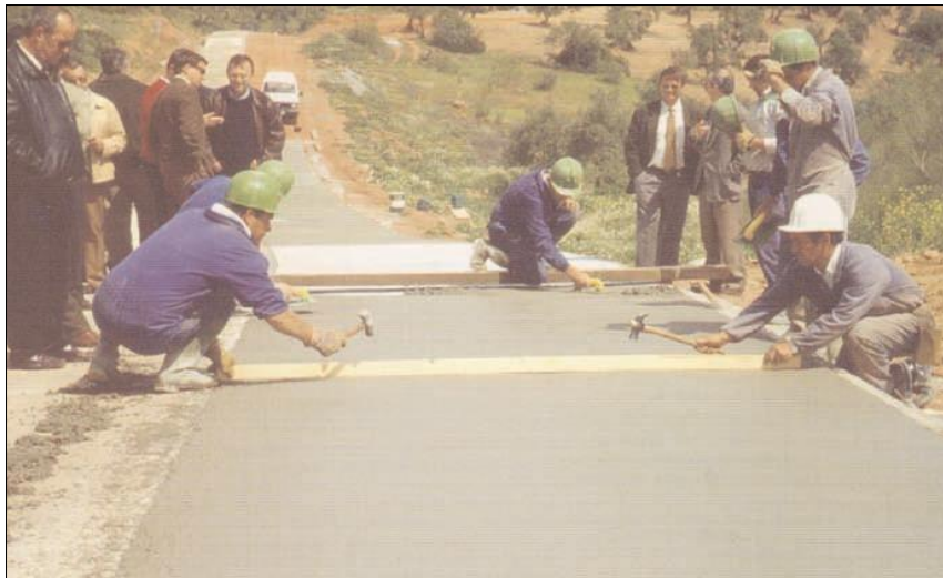
FIGURA N.º 03 ejecución de juntas en fresco (juntas, s.f.)
