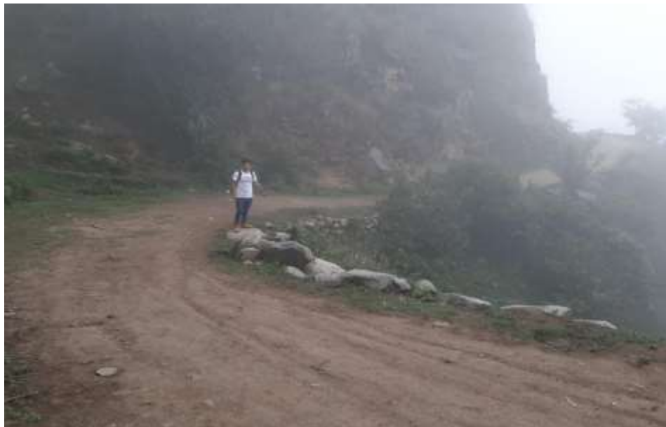
Foto 3. Curvas que no cumplen con los parámetros DG - 2018.
