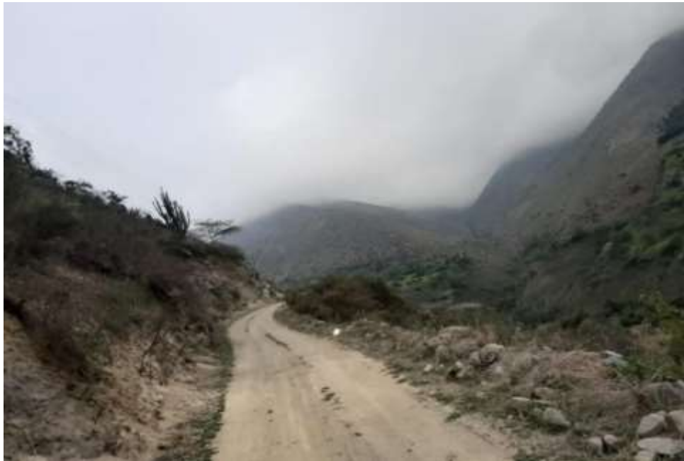
Foto 2. Pendientes muy elevadas
