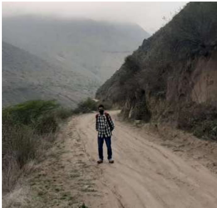
Foto 9. Derrumbes en tiempos de lluvias.
