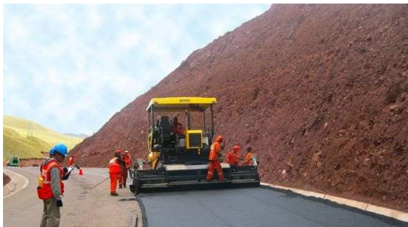
Figura 01. Construcción de carreteras.
