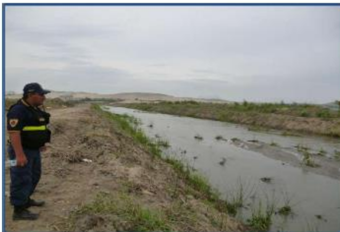
Figura 53: Río Lacramarca con sus cauces colmatados con sedimentos de arenas de grano fino a medio.
