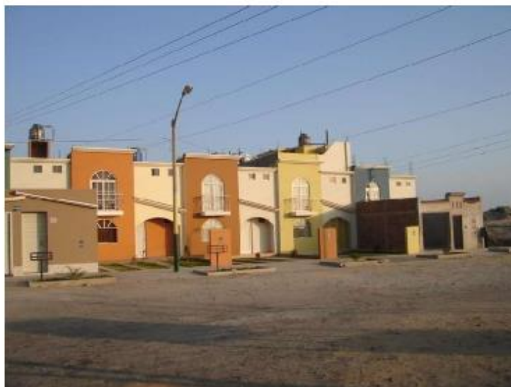
Figura 8: Imagen del terreno sobre el cual se ha realizado el trabajo geológico y geomorfológico en la ciudad de Nuevo Chimbote
