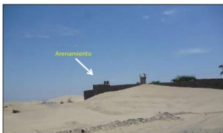
Figura 28: Las arenas eólicas varían rápidamente su geoforma y logran invadir zonas pobladas como es el caso de los muros del aeropuerto.
