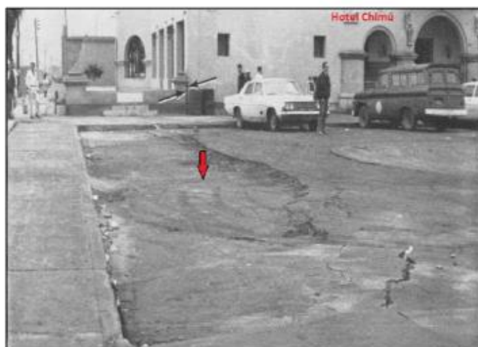
Figura 48: Inmediaciones del Hotel Chimú y suelos con asentamientos diferenciales debido a proceso de licuación de suelos a causa del sismo de 1970.
