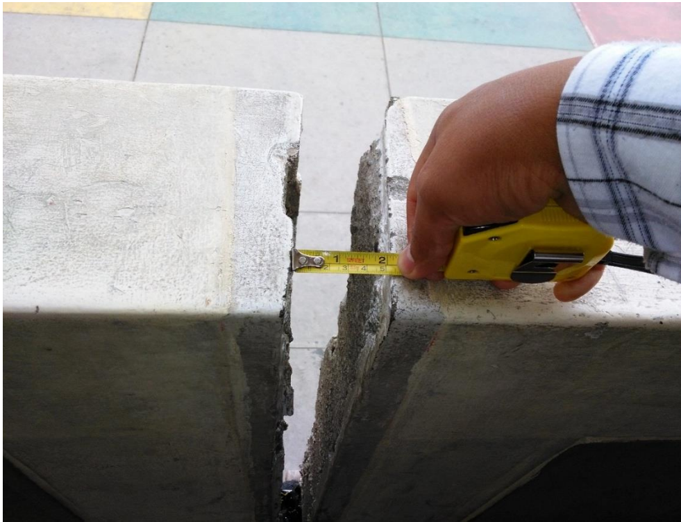
Figura 22. Toma de medidas de las juntas estructurales
