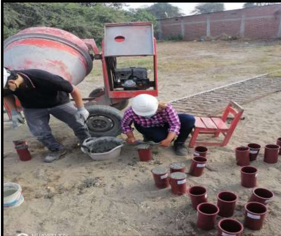
Figura 56: Vertido de concreto en los moldes
