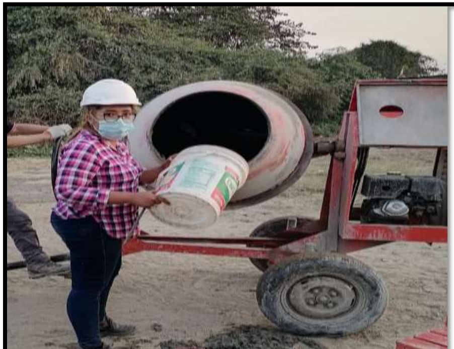
Figura 55: Preparación de la mezcla de concreto
