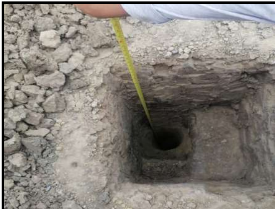
Figura 66: Excavacion de calicata
