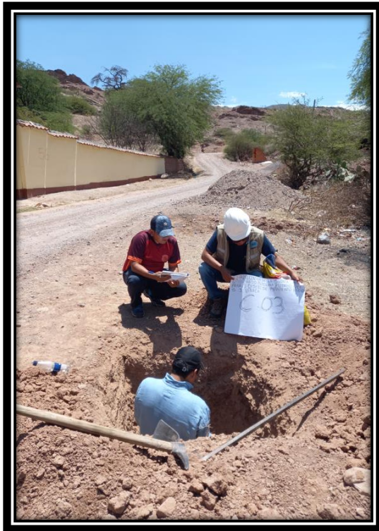
Figura 19: Calicata C-3 extrayendo muestra.
