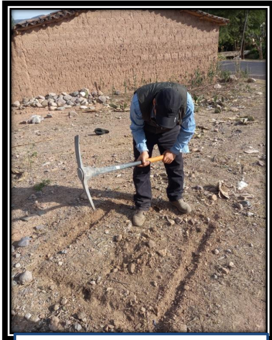
Figura 12: Señalización para realizar Calicata C-1.
