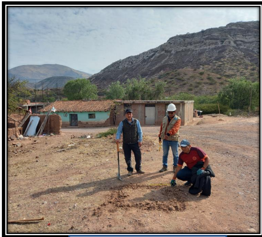
Figura 14: Señalización para realizar Calicata C-3.
