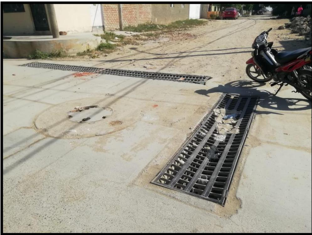
*Figura N° 09.* Estructuras de captación
