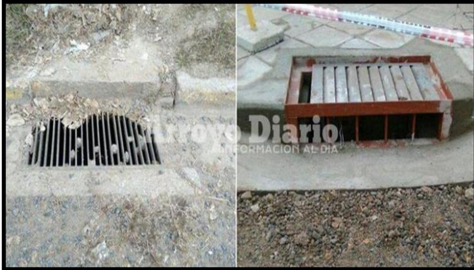
*Figura N° 10.* Estructuras de captación – Sumidero y boca de tormenta
